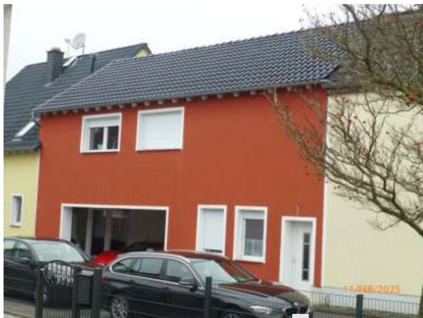
Ansicht von Süd-Osten, Zwischenbau
