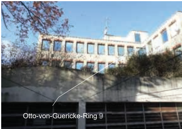
8.1.15 Ost- und Südfassaden, Blick vom Tiefgaragentor Richtung Westen
