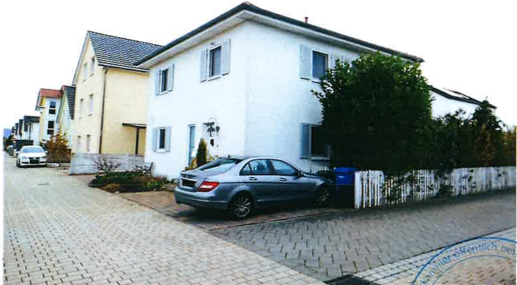
Bild 3: Ansicht von Nord-Westen
