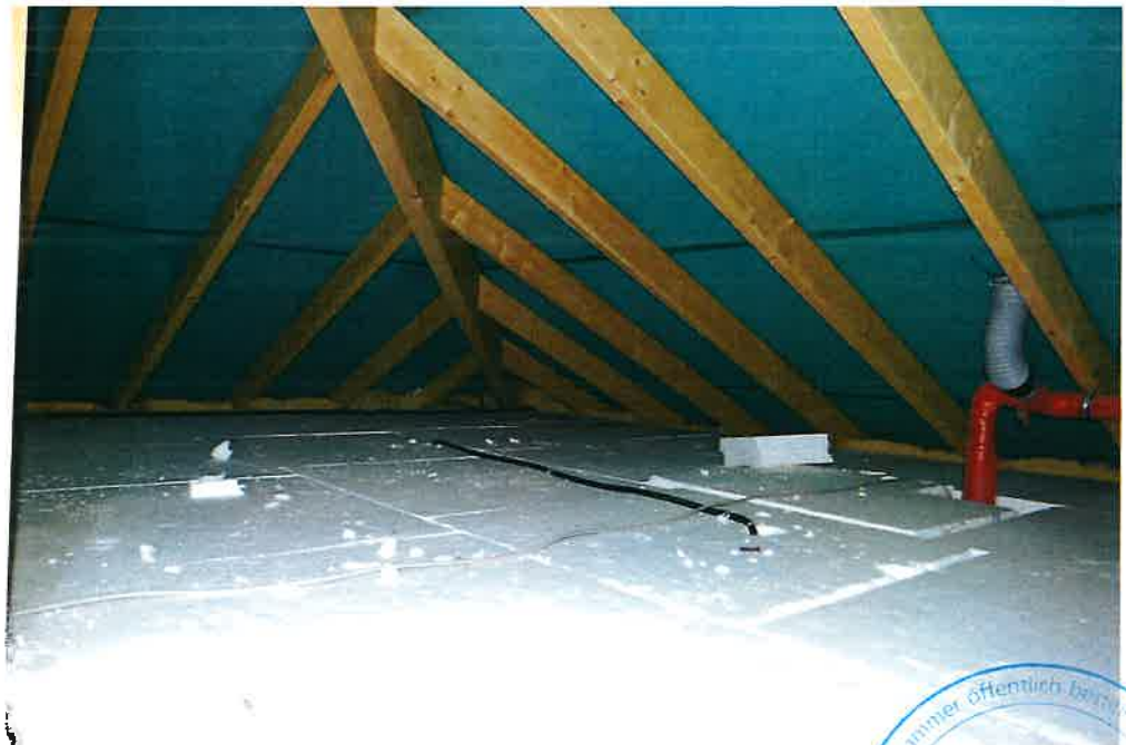
Bild 15: Wärmedämmung Dachboden z. T. lückenhaft
