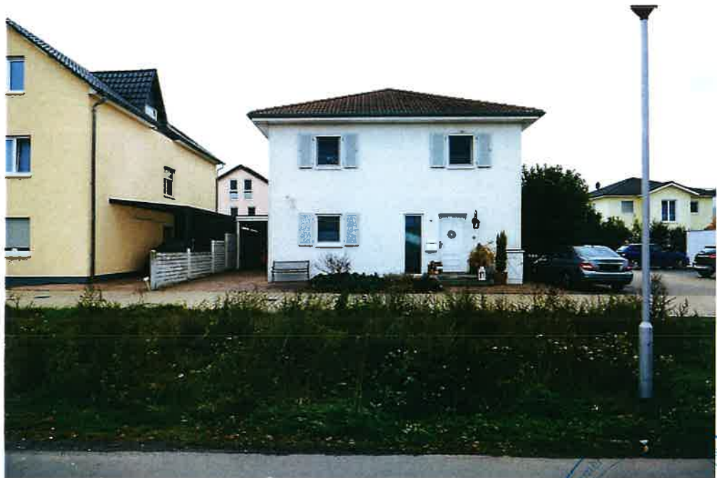
Bild 1: Ansicht von Norden
