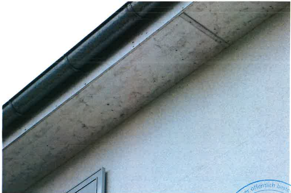
Bild 13: Anstrich der Traufschalung dringend notwendig, bereits mit Verfärbungen
