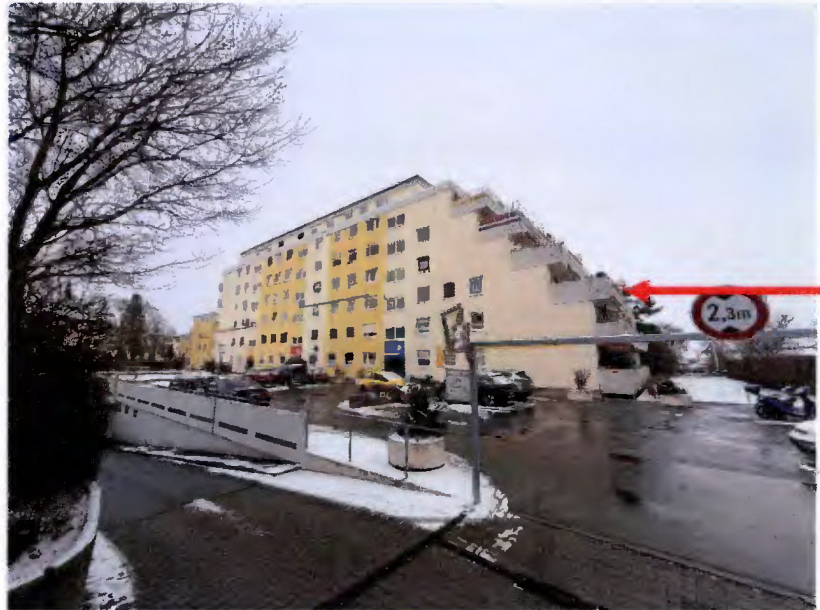
Abb. 2: Foto des SV; Anwesen Hessenring 26-32; Ansicht von Norden; Gebäudeeingangsseite; Roteintragung (Pfeil) d.d. SV; Lage der Wohnung Nr. 13 in Haus A (Hessenring Nr. 26)
