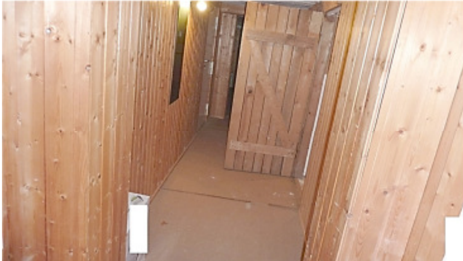
vielfach holzverkleidete Kellerwände
