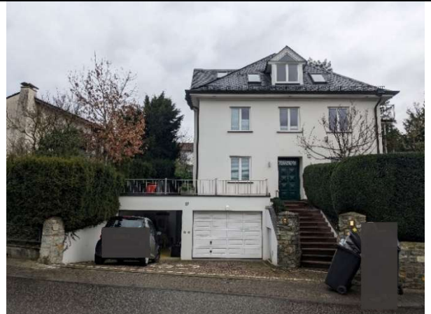
Westfassade, Blick von der Straße Richtung Osten
