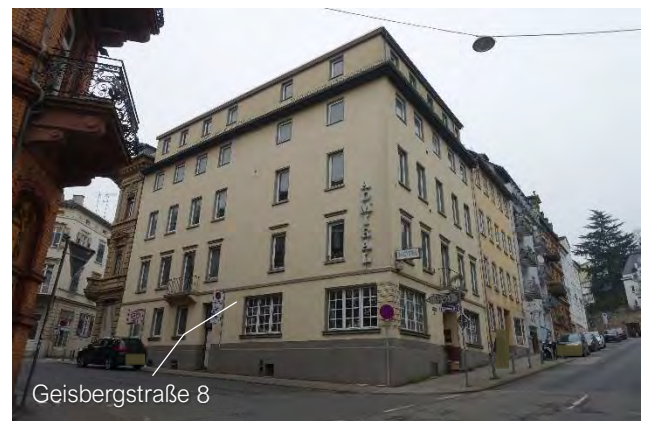
7.2.4 Südwest- und Südostfassade, Blick von der Geisbergstraße Richtung Norden
