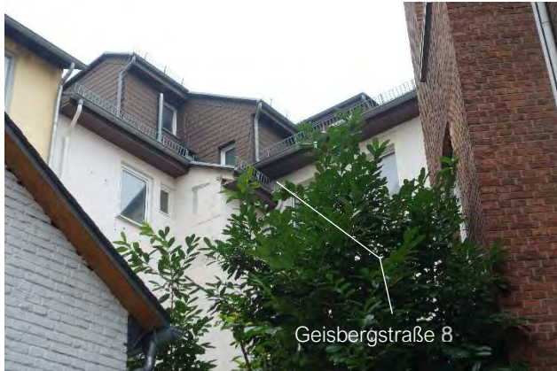
7.2.9 Hofansicht und Dachflächen, Blick vom Nachbarflurstück 190/27 Richtung Süden
