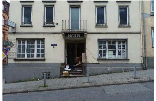
7.2.10 Südostfassade des Erd- und 1. Obergeschosses, Blick von der Geisbergstraße Richtung Nordwesten
