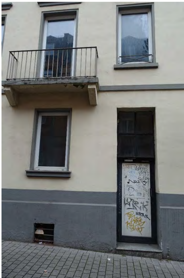
7.2.11 Nebeneingang von der Kapellenstraße, Blick von der Straße
