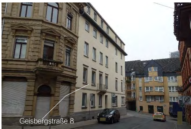
7.2.3 Südwestfassade, Blick von der Kapellenstraße Richtung Osten
