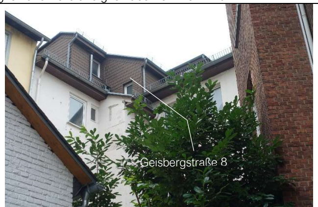
Hofansicht und Dachflächen, Blick vom Nachbarflurstück 190/27 Richtung Süden
