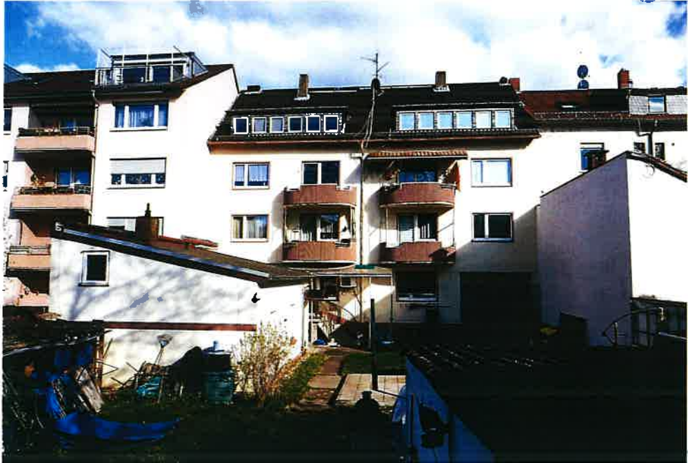
Bild 3: Rückansicht von Westen, links Hinterhaus
