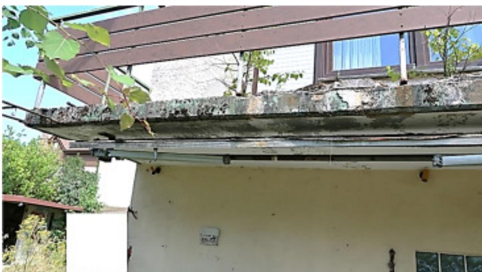
erhebliche konstruktive Schäden Balkon Seitengebäude
