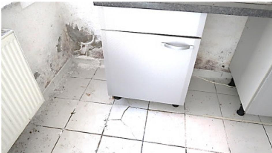
Küche EG mit Sockelfeuchteschäden / Fliesenschäden
