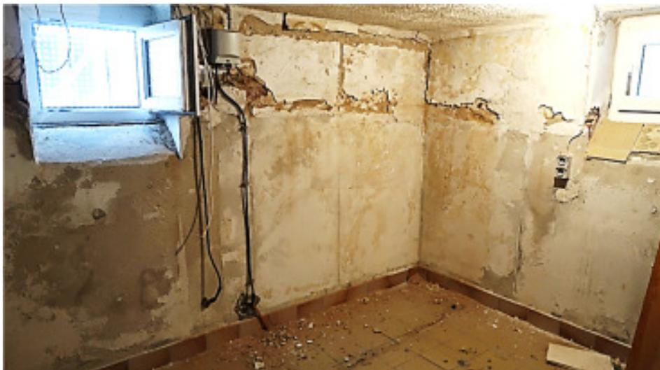
erhebl. Feuchteschäden / Putzschäden im KG –
