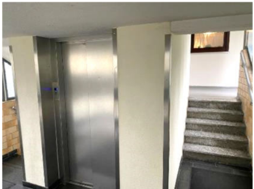
Foto 5 des SV: Treppenhaus und Personenaufzug
