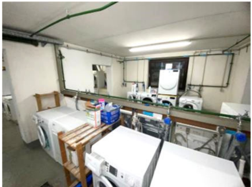
Foto 7 des SV: Waschraum
