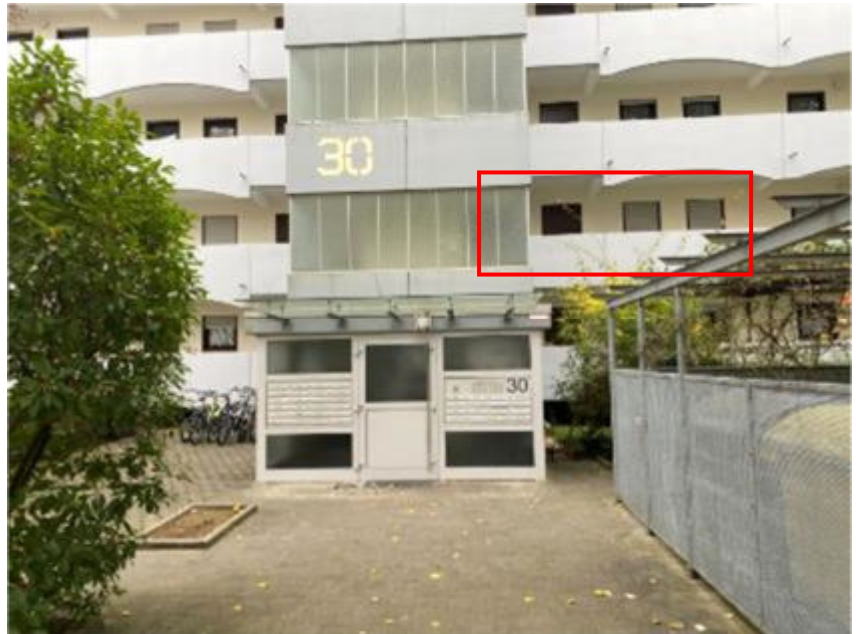
Foto 3 des SV: Hauseingang, Treppenhausvorbau; Detail Wohnung Nr. I 4; Roteintragung d.d. SV
