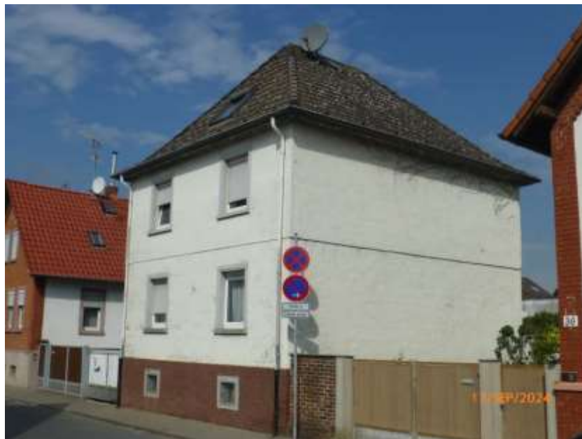
Ansicht von Süd-Osten
