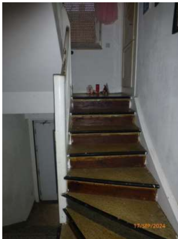
Innenansicht Erdgeschoss, Treppenhaus
