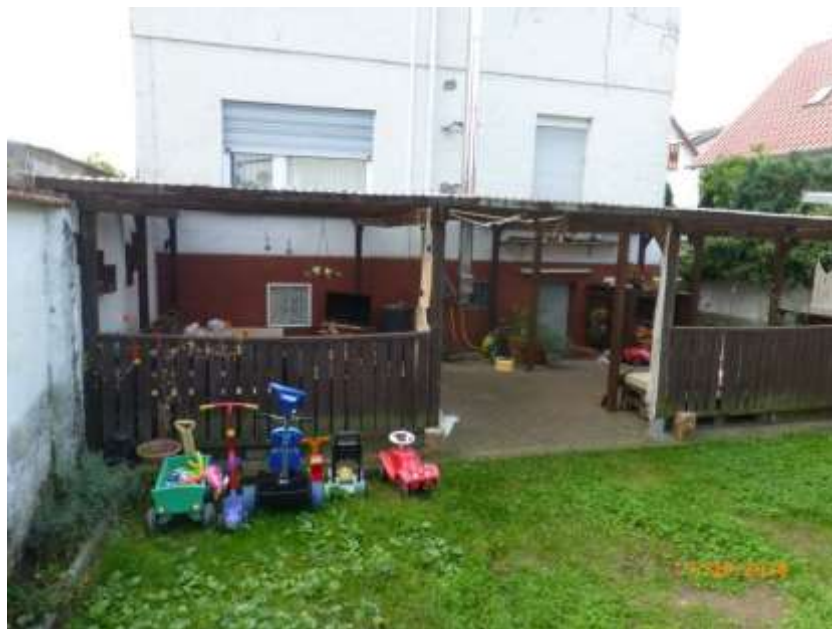
Terrasse mit Überdachung
