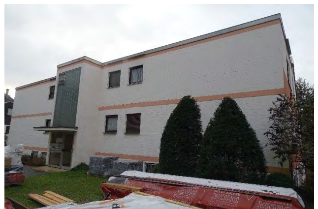
7.2.12 Nordostfassade, Haus Nr. 9, Freifläche über der Tiefgarage, Blick Richtung Süden
