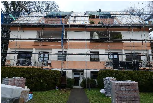
7.2.9 Südwestfassade, Haus Nr. 11, Freifläche über der Tiefgarage, Blick vom Hauseingang Haus Nr. 9 Richtung Nordosten
