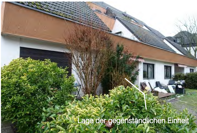
7.2.13 Südwestfassade (straßenseitige Fassade), Haus Nr. 9 Blick vom Fahrweg zur Tiefgarage Richtung Südosten
