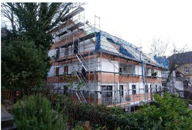
7.2.11 Nordwest- und Südwestfassade, Haus Nr. 11, Blick vom nordwestlichen Flurstück 67 Richtung Osten
