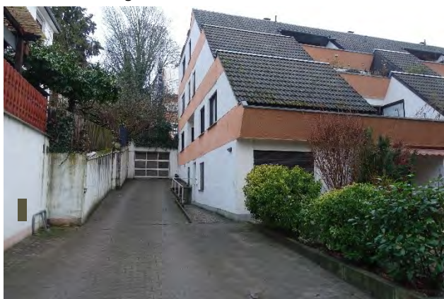
7.2.3 Südwestfassade, Haus Nr. 9, Blick von der Straße Richtung Nordosten
