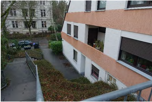
7.2.7 Südostfassade, Haus Nr. 9, Blick von der Erschließungstreppe zur Straße Richtung Westen
