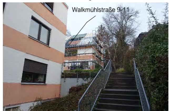
7.2.4 Nordwest- und Südwestfassade, Haus Nr. 9, Blick von der Straße Richtung Osten
