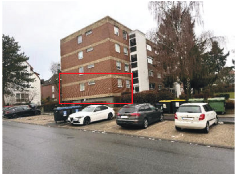
Foto 1 des SV: Frank-Wedekind-Straße 4, 6, 8 Ansicht von Südosten; Gebäudeeingangsseite, Stellplatzflächen (Flst. 139); Roteintragung d.d. SV: Lage der Wohnung Nr. 25 in Haus 4; Anonymisierung d.d. SV
