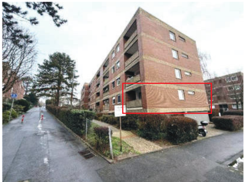
Foto 2 des SV: Frank-Wedekind-Straße 4-14; Ansicht von Südwesten, Gebäuderückseite; Roteintragung d.d. SV: Lage der Wohnung Nr. 25
