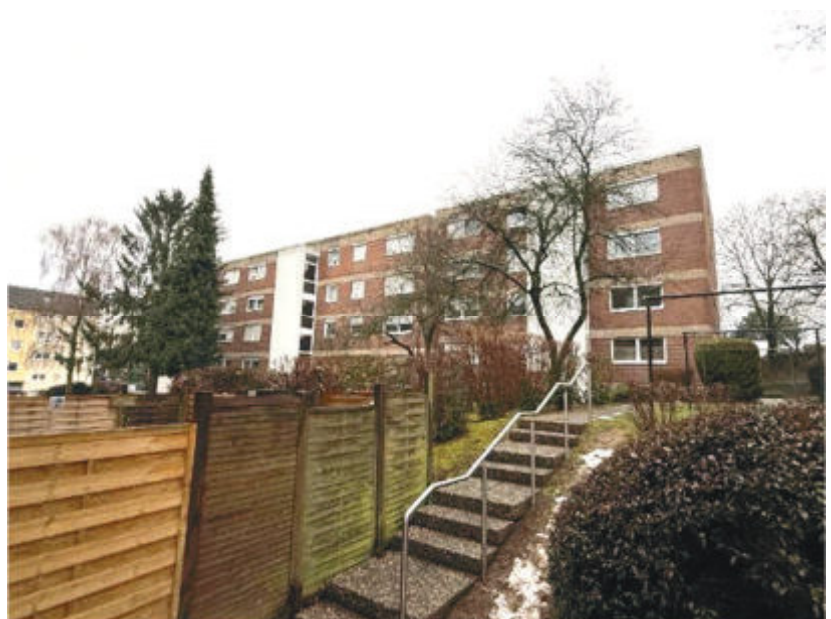
Foto 4 des SV: Frank-Wedekind-Straße 4, 6, 8; Ansicht von Nordosten; Gebäudeeingangsseite
