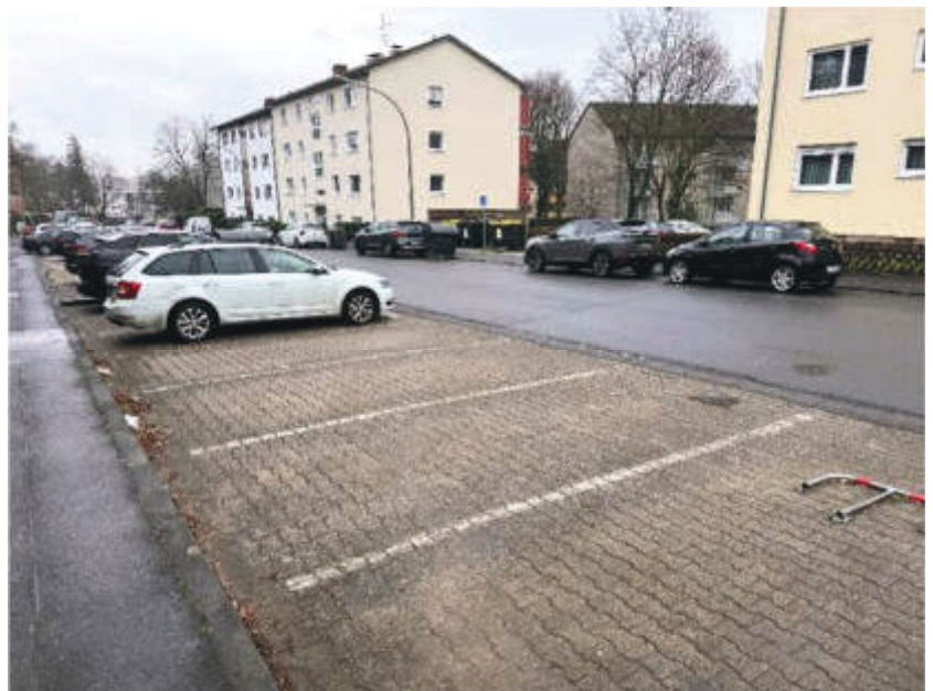
Foto 6 des SV: Stellplatzflächen der Wohnanlage Frank-Wedekind-Straße Nr. 4 - 14
