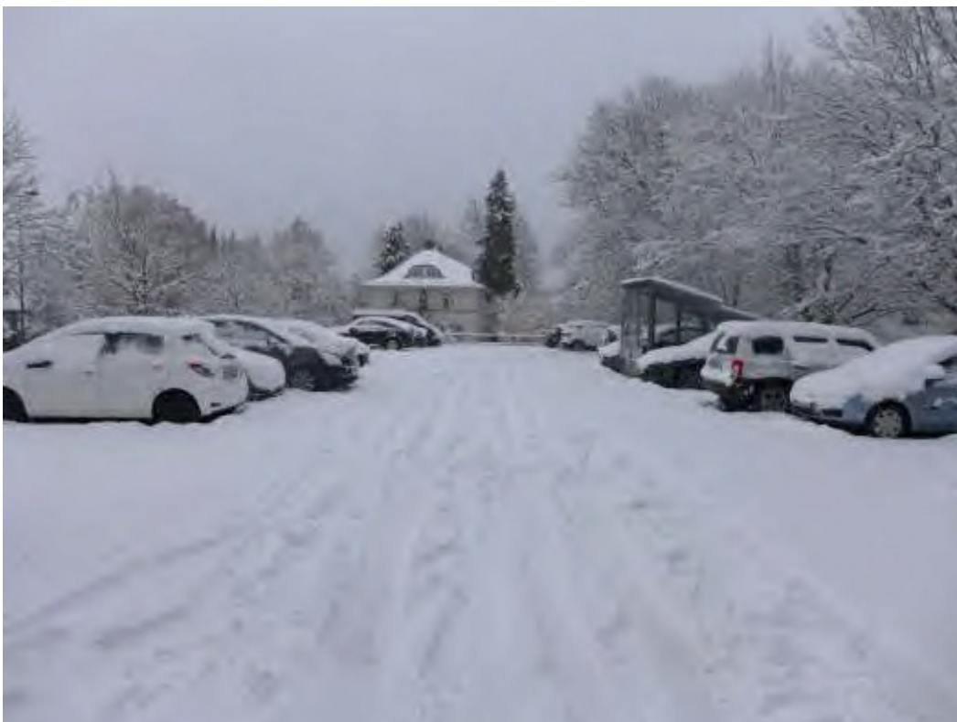
8 Stellplatzfläche (Parkdeck) auf Garagendach
