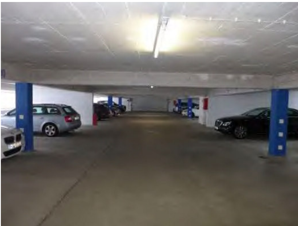
16 Tiefgarage, unteres Parkdeck
