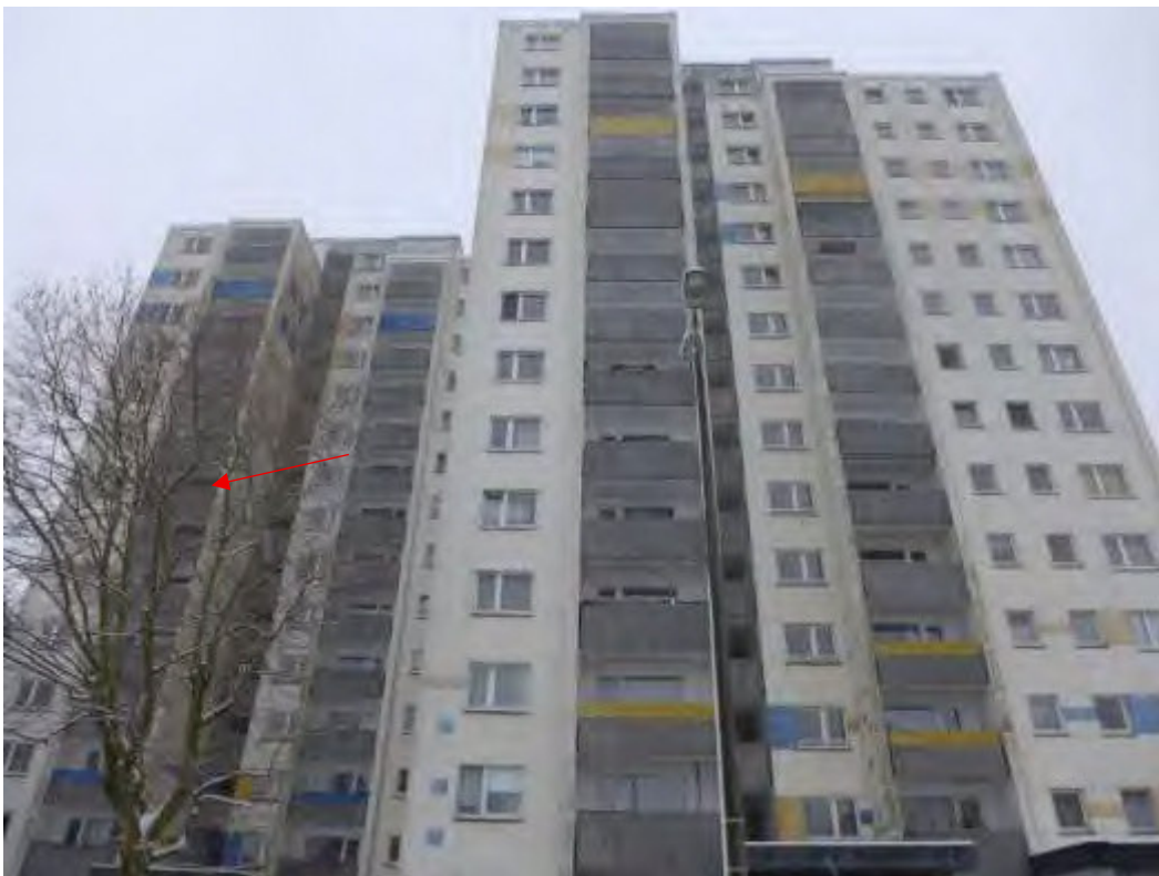
2 Front-/Straßenansicht Haus 1 (links) und Haus 3 (rechts), Bewertungsobjekt markiert
