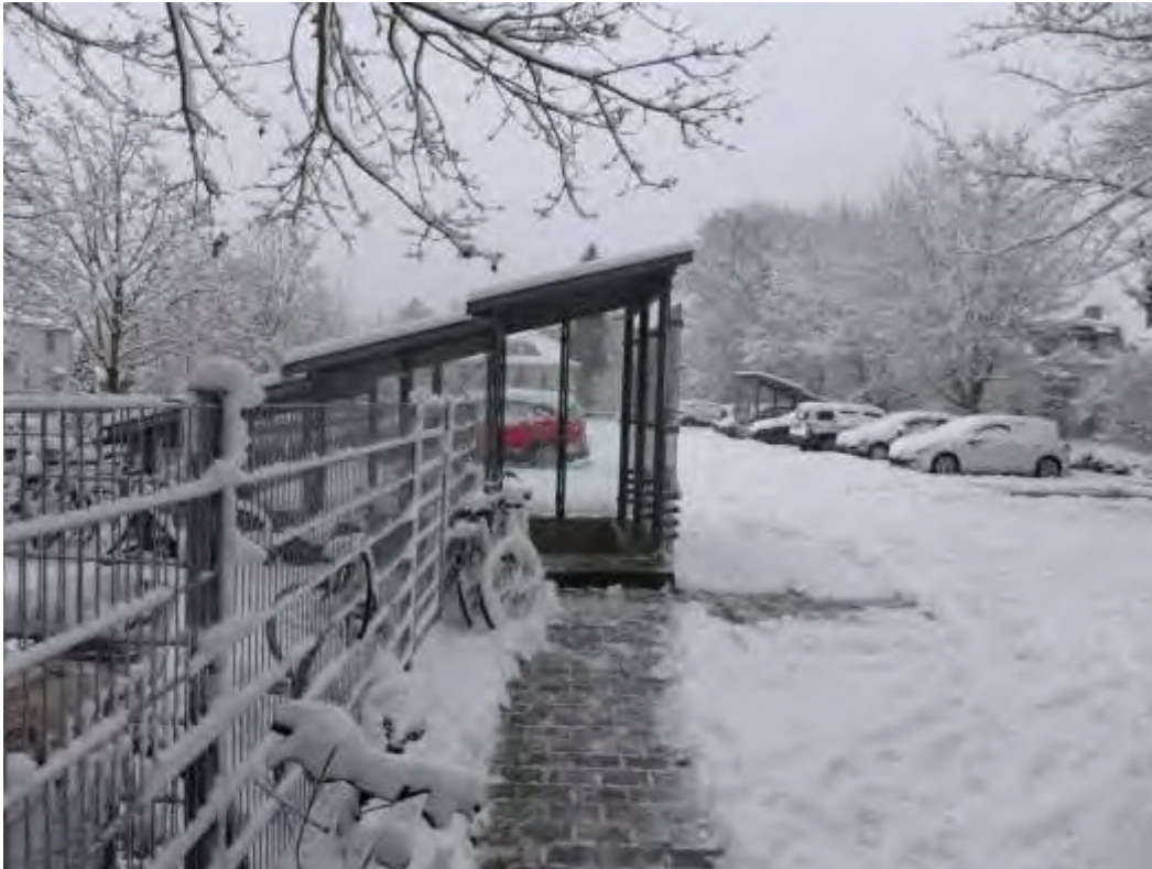
13 a Zugang Tiefgarage
