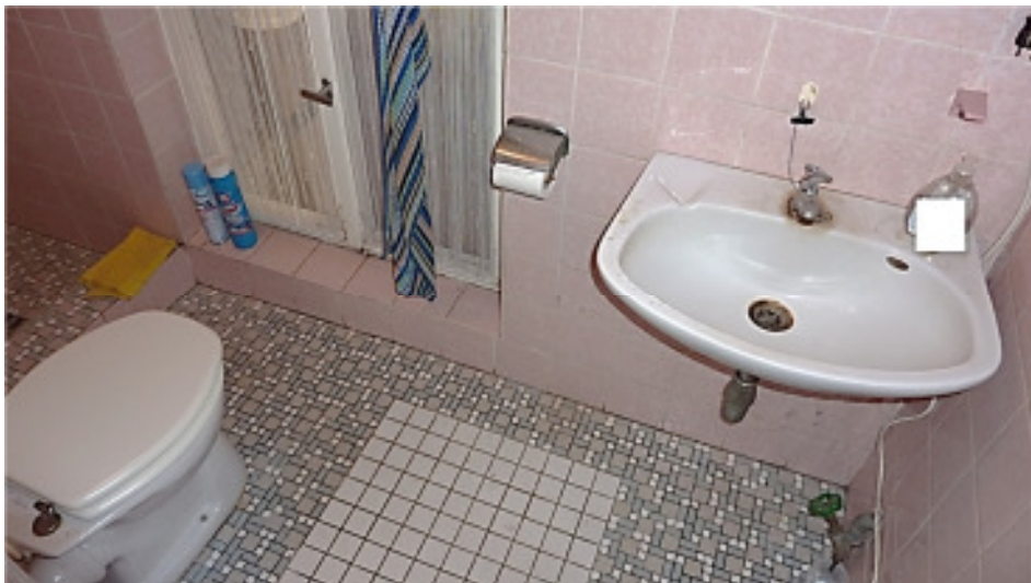
alte Dusche/WC hinter der Garage
