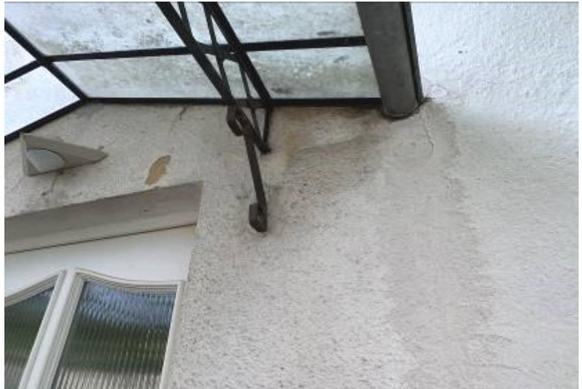
**Abb. 2:** Foto des SV; z.T. Fassade schadhaft, Putzverfärbungen, -ablösungen, -risse
