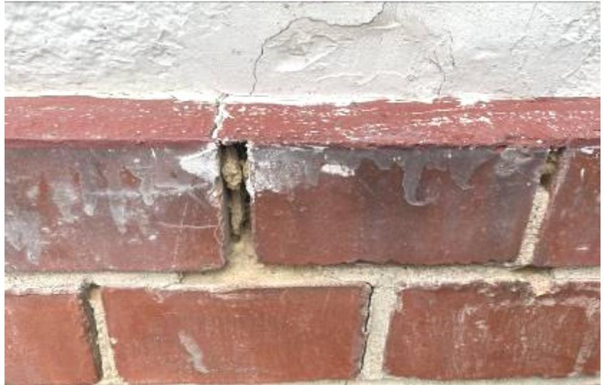
**Abb. 3:** Foto des SV; z.T. Sockel schadhaft, Fugenausbrüche
