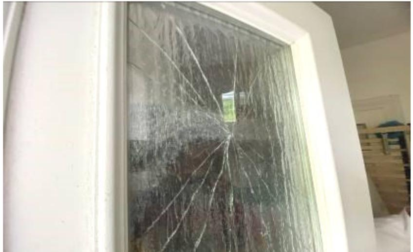
**Abb. 6:** Foto des SV; Kellertür schadhaft, Glasschaden
