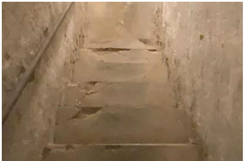
**Abb. 7:** Foto des SV; z.T. Treppenstufen schadhaft (KG)
