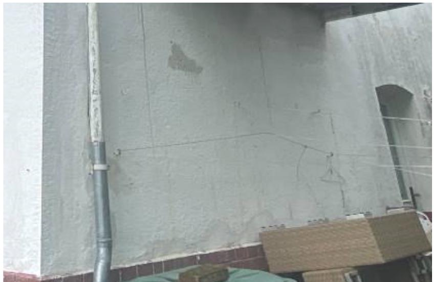
Abb. 1: Foto des SV; z.T. Fassade schadhaft, Putzverfärbungen, -risse
