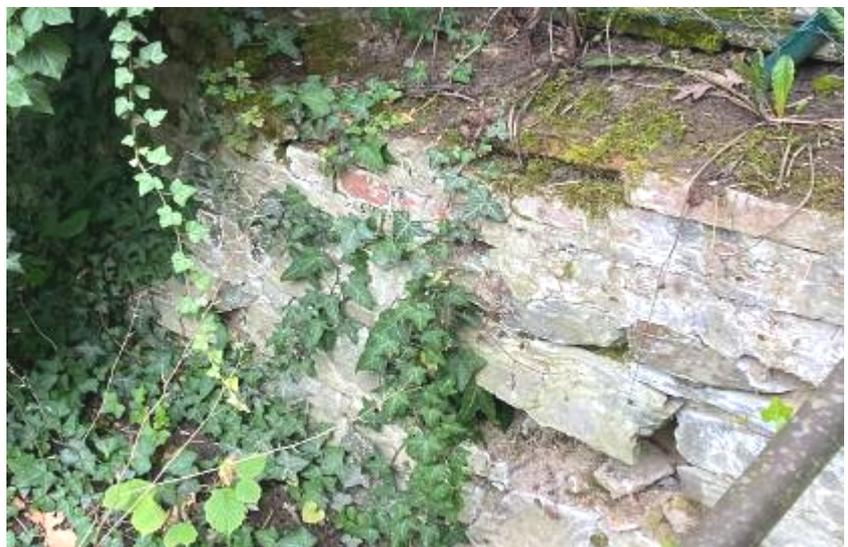
**Abb. 4:** Foto des SV; z.T. Garten-Stützmauer schadhaft, Steinausbrüche
