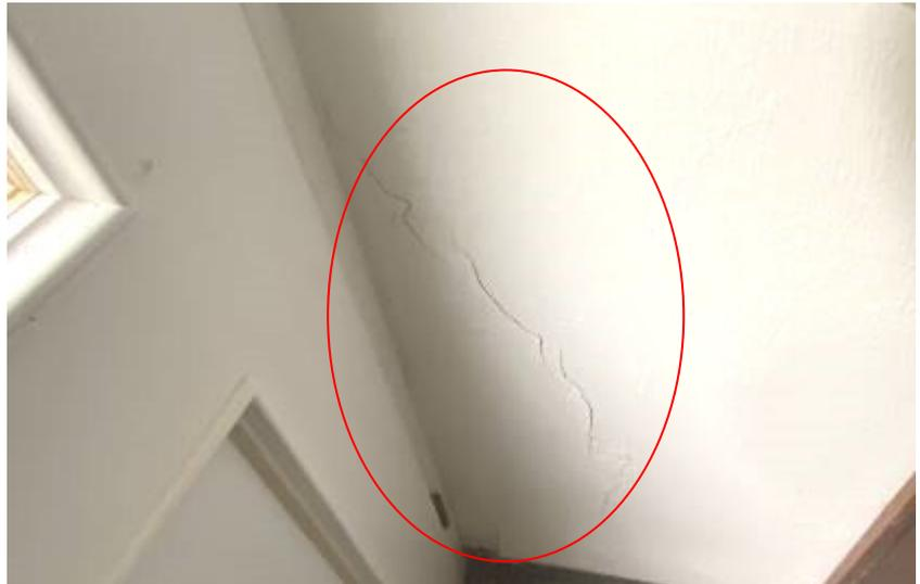
**Abb. 5:** Foto des SV; z.T. Deckenbekleidung Treppenhaus schadhaft; Putzrisse; Rotmarkierung d.d. SV
