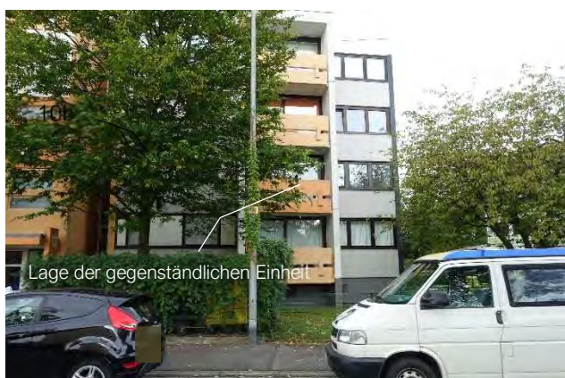
7.2.11 „Im Sempel 13“ Nordostfassade, Blick von der Straße Richtung Südwesten
