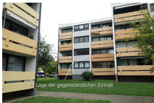
7.2.12 „Im Sempel 13“, Südwestfassade, Blick von der Freifläche Richtung Nordosten
