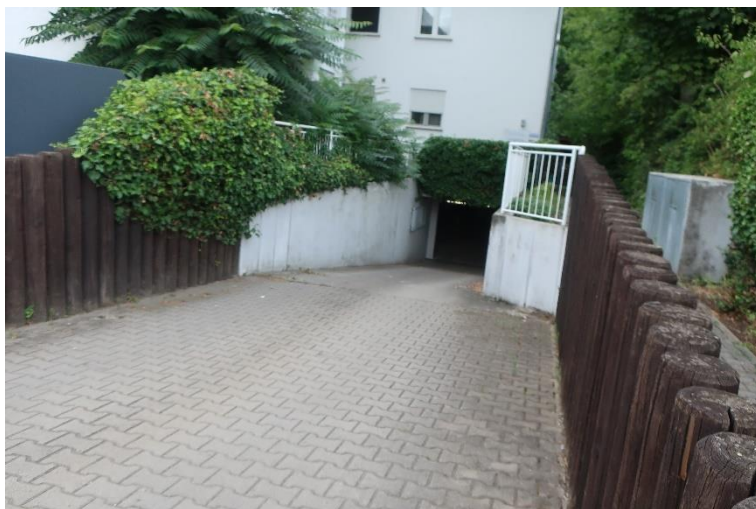
Zufahrt zur Tiefgarage
