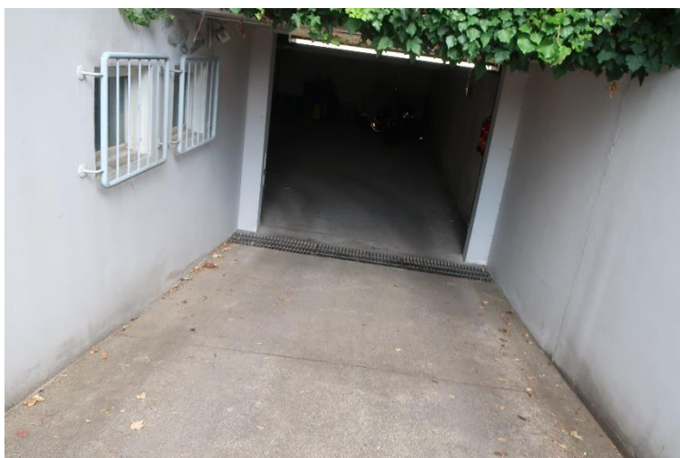
Zufahrt zur Tiefgarage
