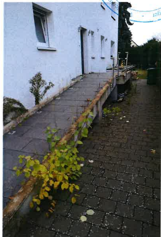
Bild 10: die Rampe ist nicht behindertengerecht, da zu steil
