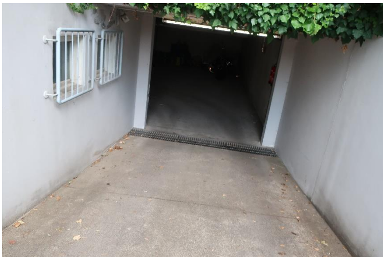
Zufahrt zur Tiefgarage
