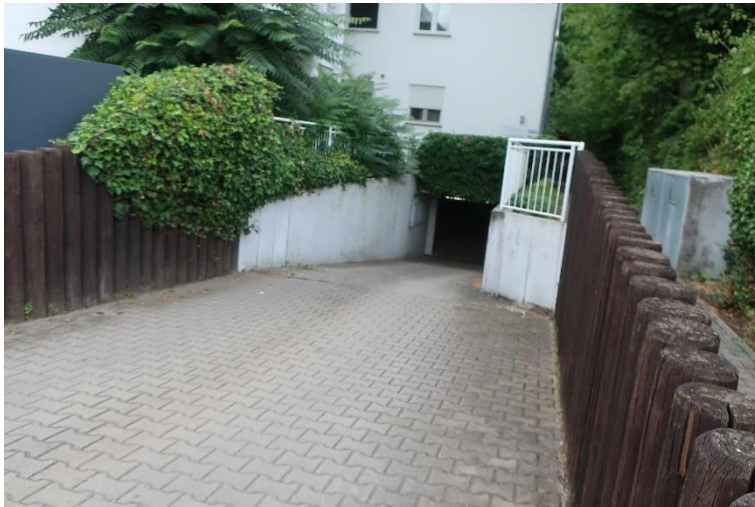
Zufahrt zur Tiefgarage
