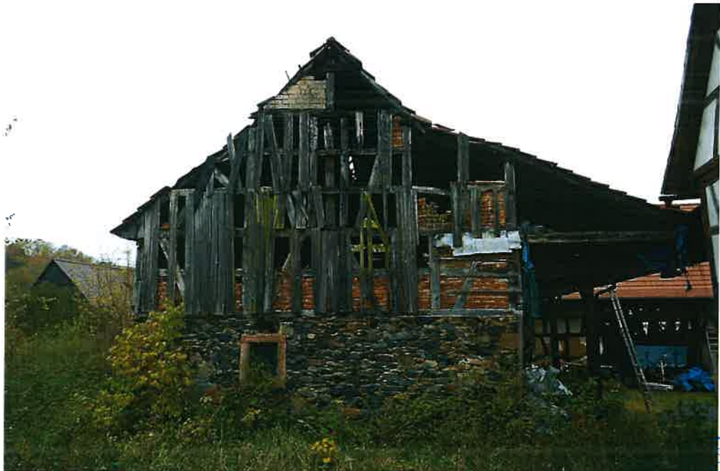
Bild 15: Scheune im Westen mit erheblichem Instandhaltungsrückstau (abgängig), laut Akte des Denkmalschutzes ist die Scheune jedoch zu erhalten.
