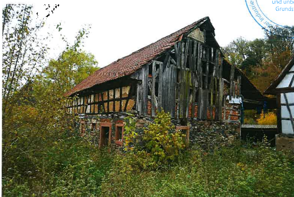
Bild 14: Scheune im Westen mit erheblichem Instandhaltungsrückstau (abgängig), laut Akte des Denkmalschutzes ist die Scheune jedoch zu erhalten.
