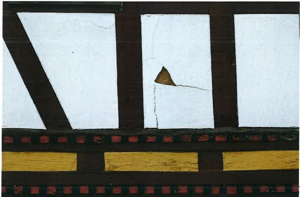
Bild 9: Putzbeschichtung der Gefache Wohnhaus z. T. defekt
