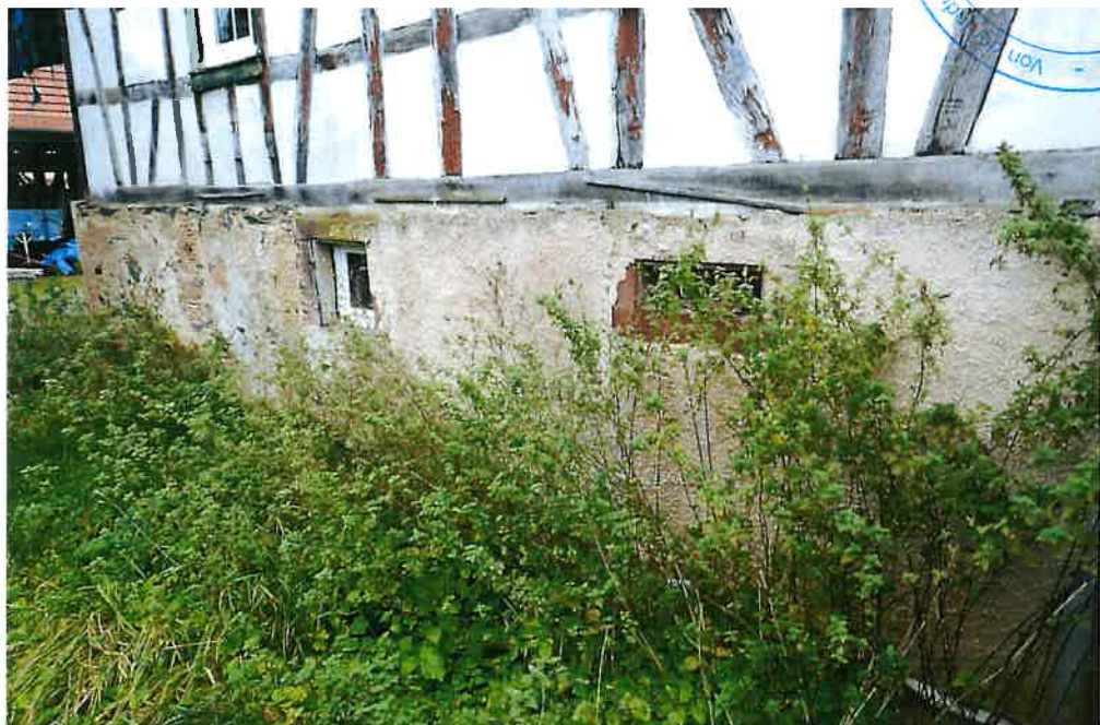
Bild 6: Sockel Putz Wohnhaus z. T. defekt
