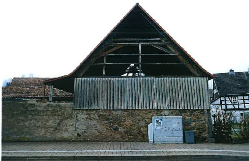
Bild 13: Scheune Nord, Bekleidung Fassade Ost mit Wellenblechen (asbesthaltig)
