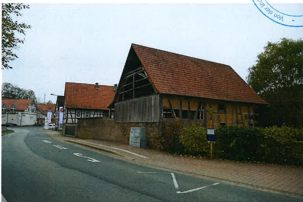
Bild 12: Scheune Nord, Gefache z. T. offen, im Hintergrund Wohnhaus
