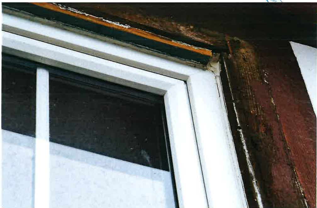
Bild 8: Fensteranschlüsse Wohnhaus z. T. defekt
