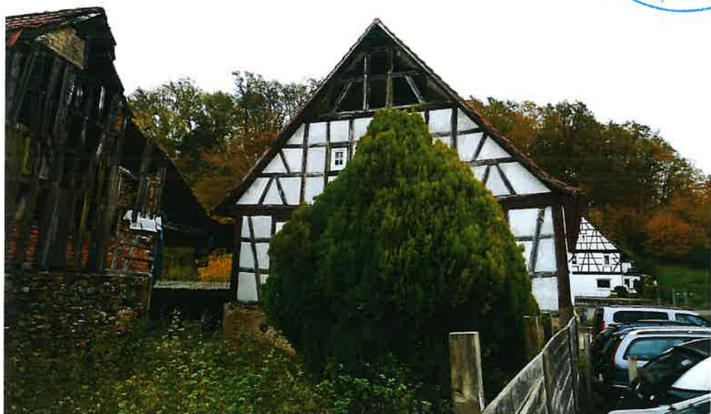
Bild 10: Gefache im Giebel Wohnhaus, links Scheune West z. T. offen
