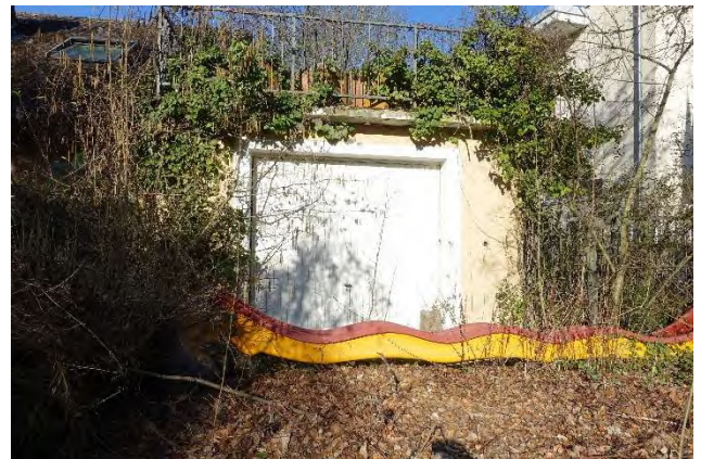
8.1.10 Garage, Blick vom Gehweg Richtung Nordwesten
