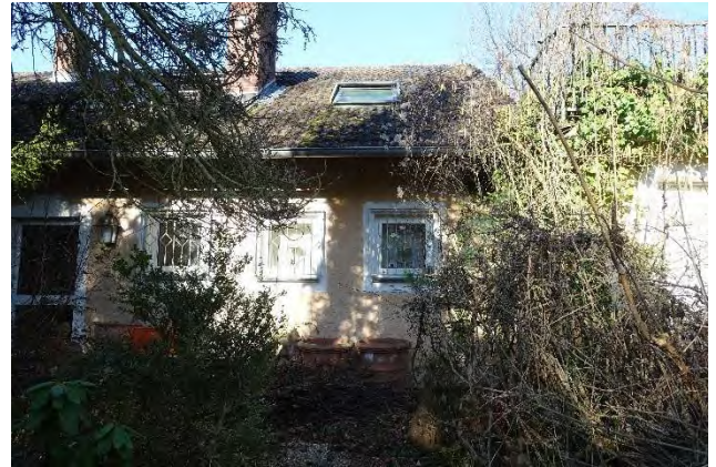
8.1.8 Teilbereich der Südostfassade, Blick vom Gehwege Richtung Nordwesten
