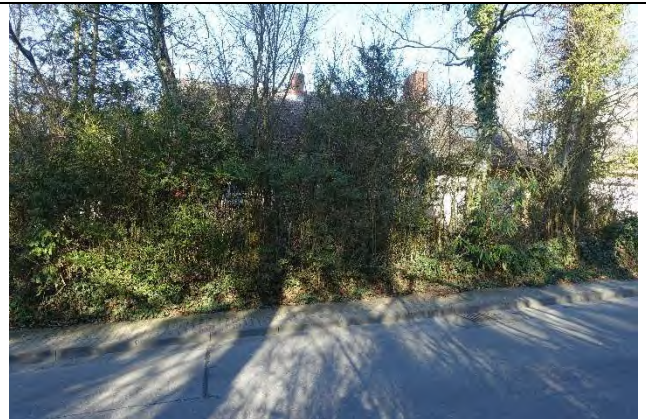
Südostansicht, Blick von der Straße Richtung Nordwesten
