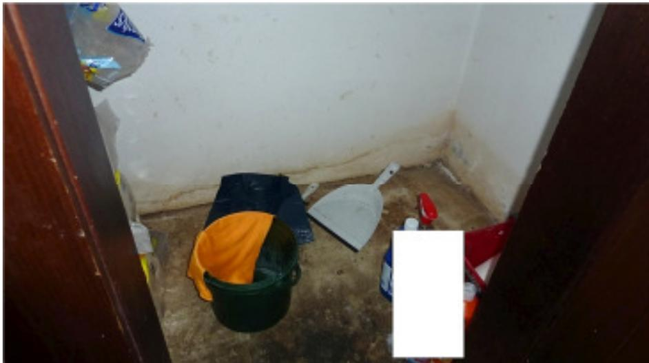
Feuchtigkeitsschäden / Putzschäden im Kellersockelbereich
