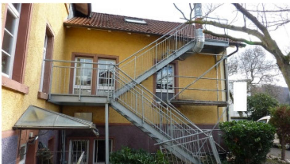
Fluchttreppe als Stahlkonstr. mit schräg stehender Stahlstütze und
