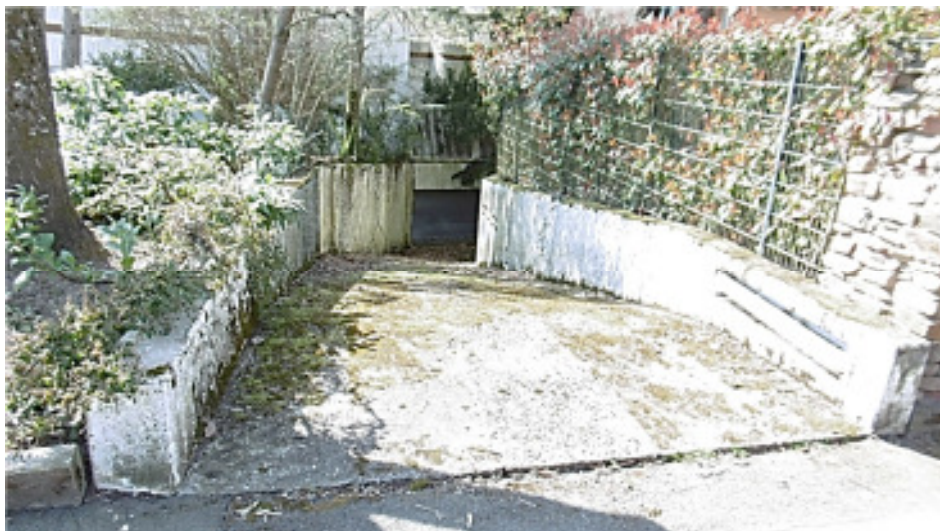
tiefliegende Garage mit steiler, nicht befahrbarer Zufahrt / nur als Lager o.ä. zu nutzen (insg. mit Abnutz.ersch. / Schadstellen)
