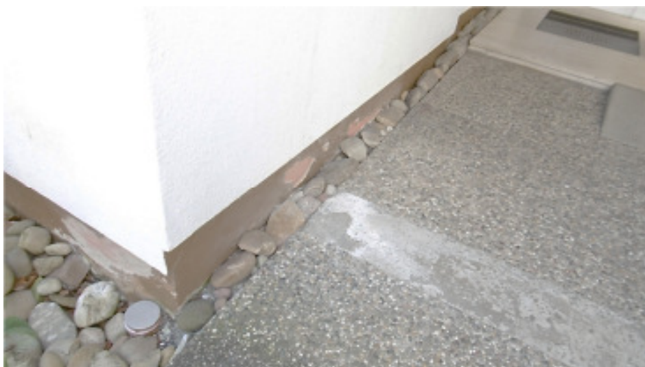
Sockelputzschaden (partiell)
