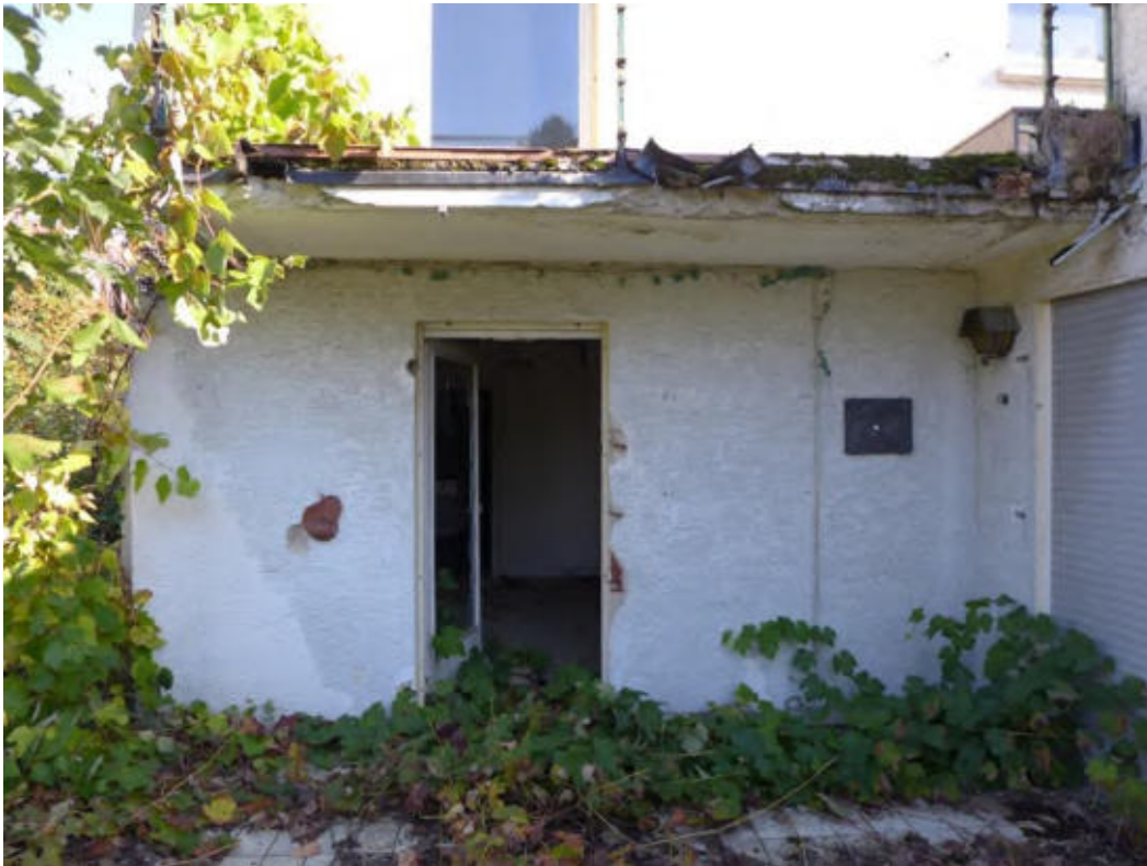
17 Eingangsbereich Heuchelheimer Straße 38
