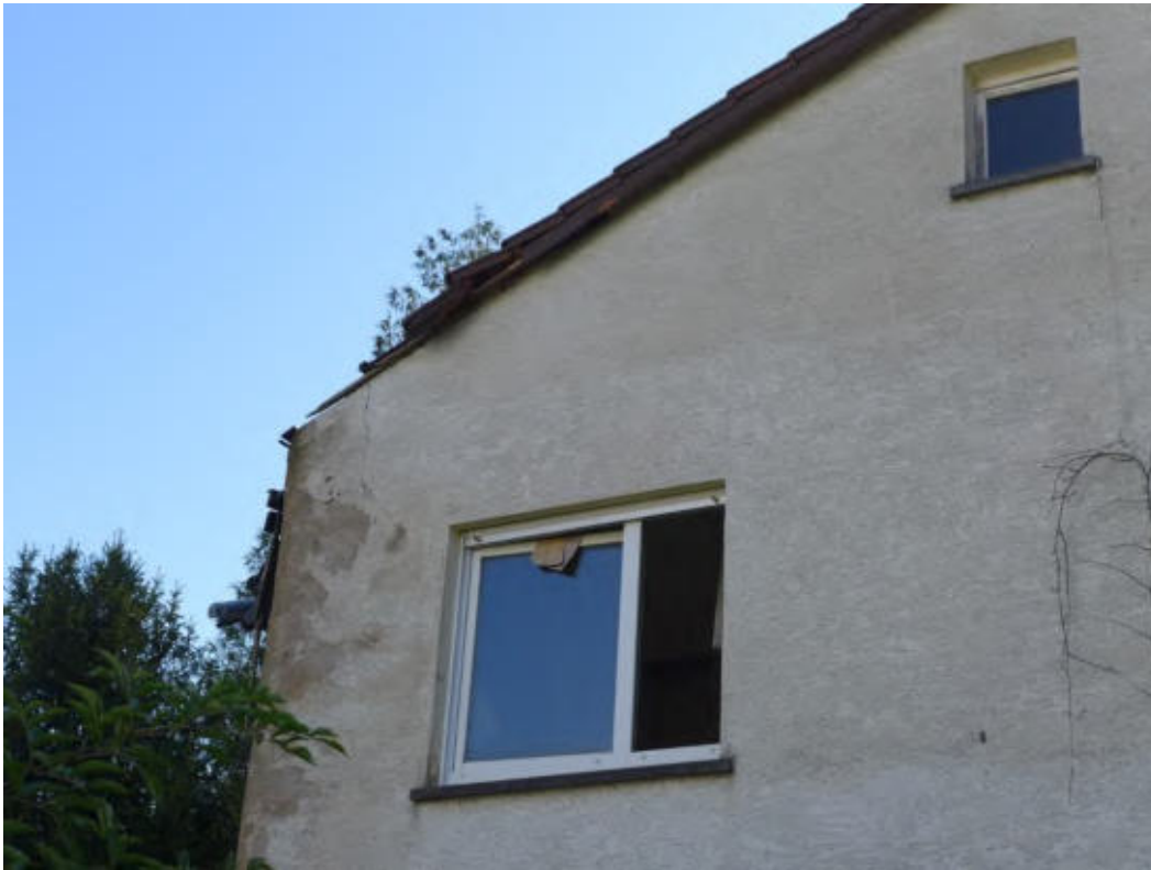
15 schadhafte Dacheindeckung
