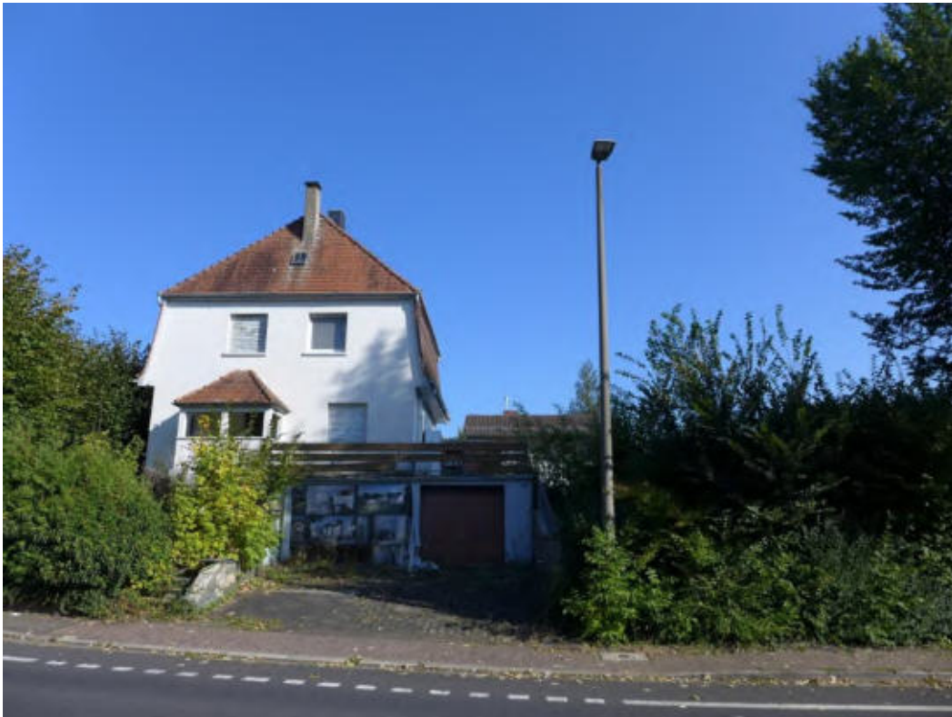
5 Straßenansicht Altbau (Heuchelheimer Straße 40) (Südansicht)
