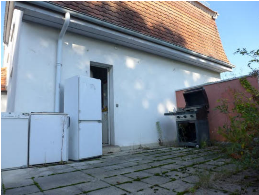
9 Terrasse, Ostansicht Heuchelheimer Straße 40 (vor Ort mit Nr. 38 bezeichnet)
