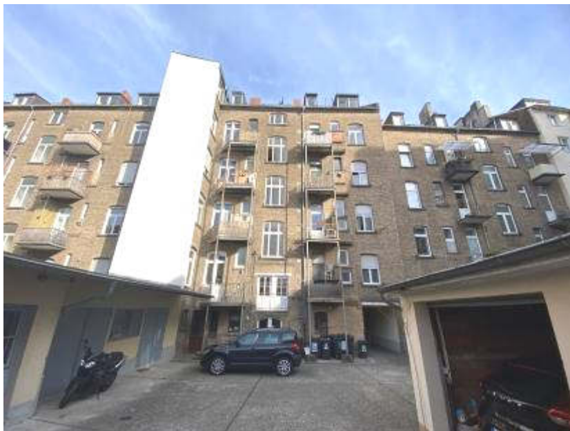
Foto des SV: Ansicht von Westen; Vorderhaus-Rückseite, Innenhof
