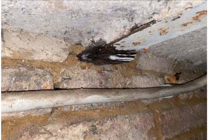
**Abb. 3:** Foto des SV; Tiefkeller; Korrosionen der Stahlträger der Decke
