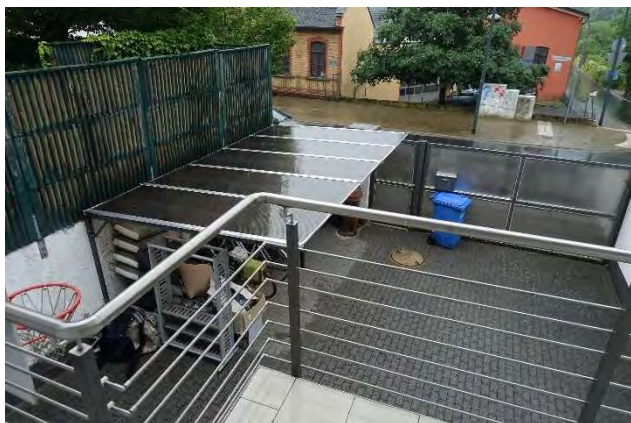
7.2.9 Hofbereich mit Überdachung, Blick vom Balkon im Erdgeschoss Richtung Südosten
