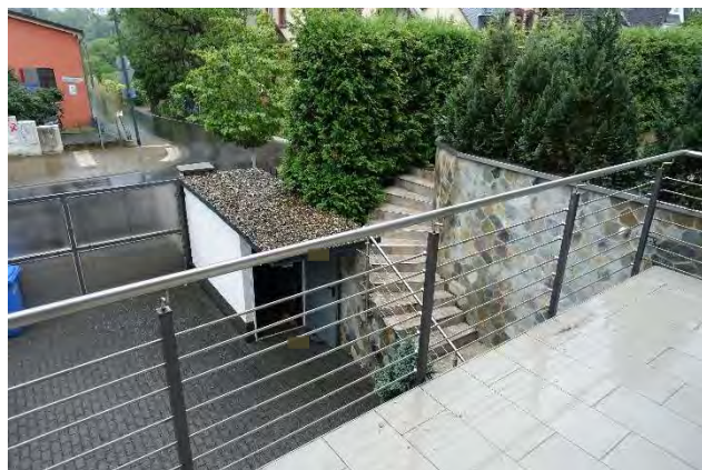
7.2.10 Schuppen und Treppe vom Hof, Balkon und Hecke im Erdgeschoss, Blick Richtung Süden
