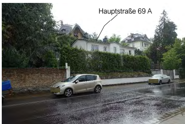
7.2.3 Südwest- und Südostfassade, Blick von der Hauptstraße Richtung Norden
