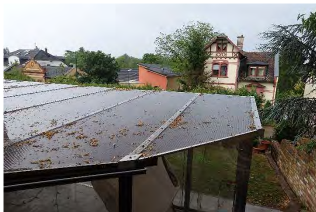
7.2.8 Dachfläche Wintergartenanbau, Blick von der südwestlichen Grundstücksgrenze Richtung Osten
