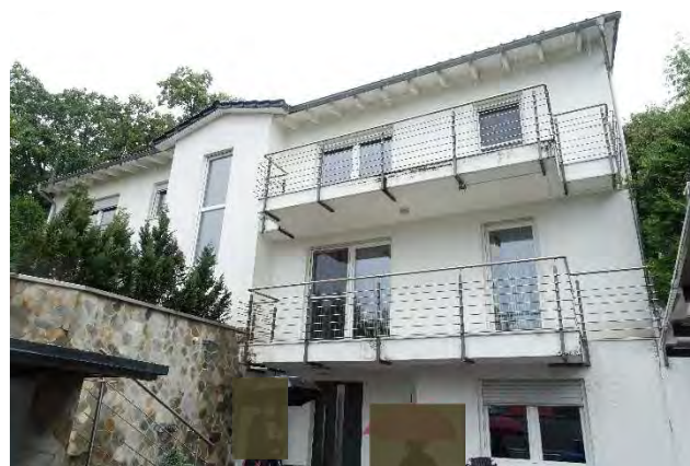
7.2.6 Südostfassade, Blick vom Hof (Eingangsebene) Richtung Nordwesten
