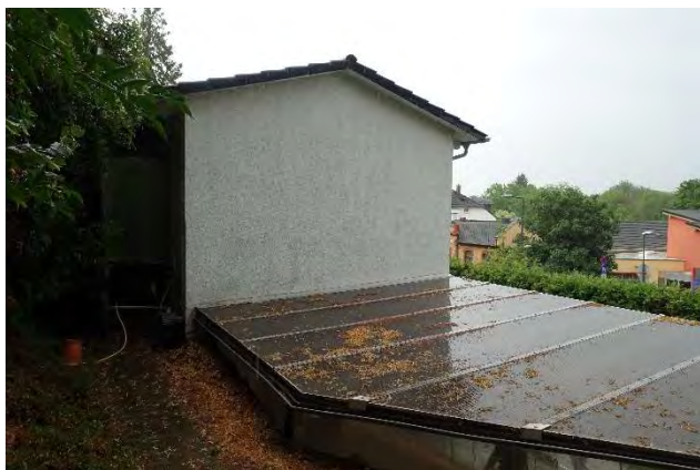
7.2.7 Nordwest- und Südwestfassade, Wintergartenanbau, Blick von der südwestlichen Grundstücksgrenze Richtung Nordosten
