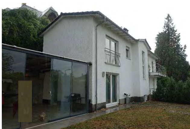
7.2.5 Südwest- und Südostfassade, Blick von der Grünfläche im Erdgeschoss (eine Ebene oberhalb der Eingangsebene) Richtung Norden
