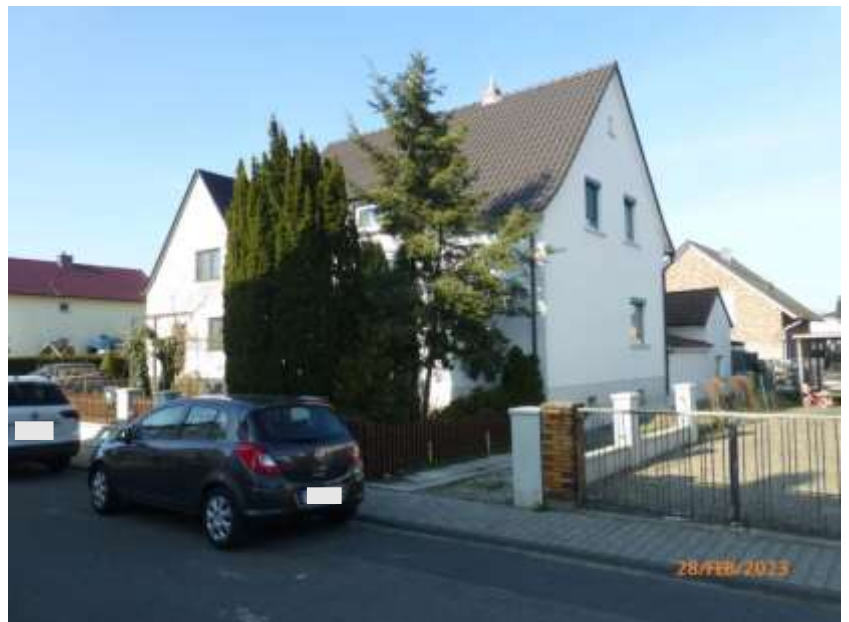
Ansicht von Süd-Osten
