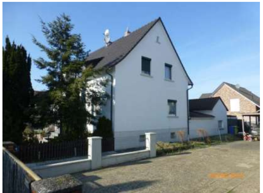
Ansicht von Süd-Osten
