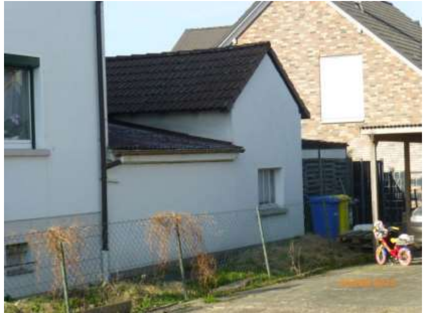
Ansicht von Süd-Osten
