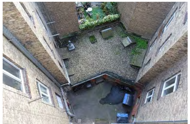
8.1.14 Hoffassaden, Nebengebäude im Hof, Blick vom Treppenhaus an der Südostfassade zum Hof
