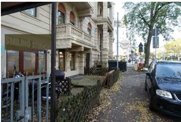
8.1.9 Teilausschnitt der Nordfassade, Blick vom Gehweg der Dotzheimer Straße Richtung Westen
