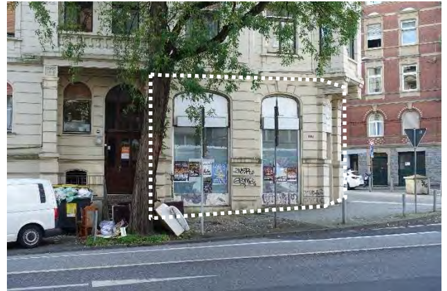
8.1.8 Teilausschnitt der Nordfassade, Blick vom gegenüberliegenden Gehweg der Dotzheimer Straße Richtung Süden
