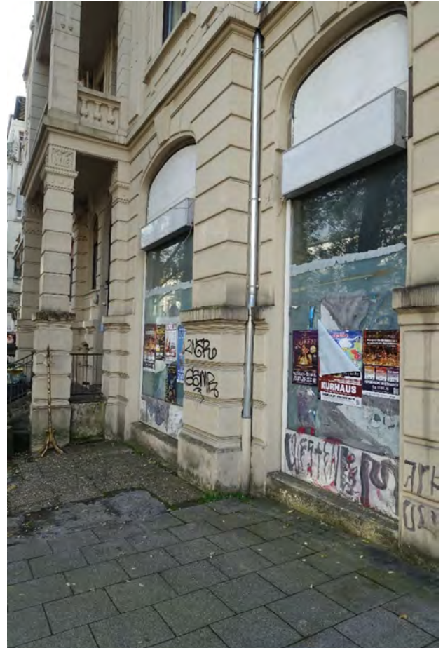
8.1.12 Teilausschnitt der Nordfassade, Hauseingang, Blick vom Gehweg der Dotzheimer Straße Richtung Südosten
