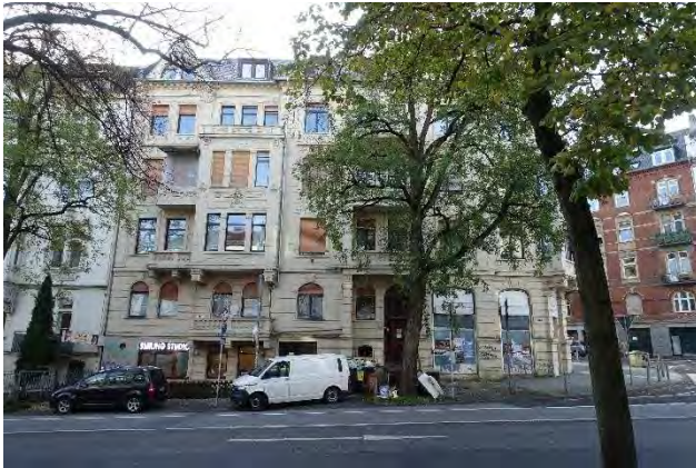
8.1.7 Nordfassade, Blick vom gegenüberliegenden Gehweg der Dotzheimer Straße Richtung Süden
