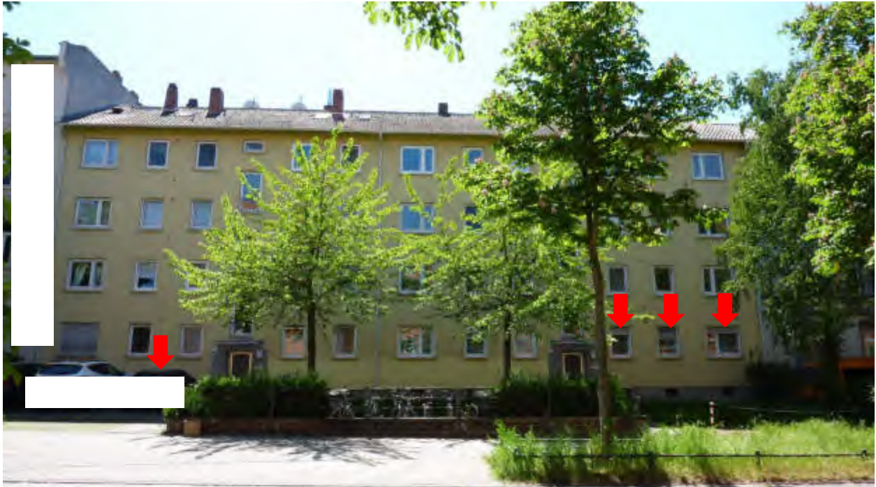
Straßenansicht mit Wohnung Nr. 2 im EG rechts und SNR an dem Pkw-Stellplatz im Freien STP 9 (links)
