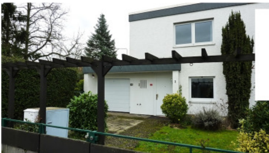
Vorgarten / Zugang Haus
