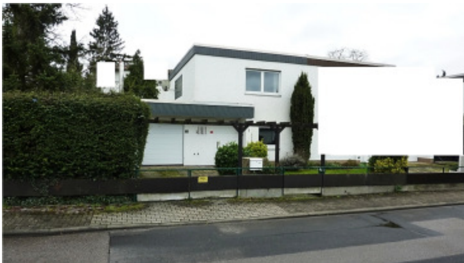
linke Doppelhaushälfte / Eingangsbereich
