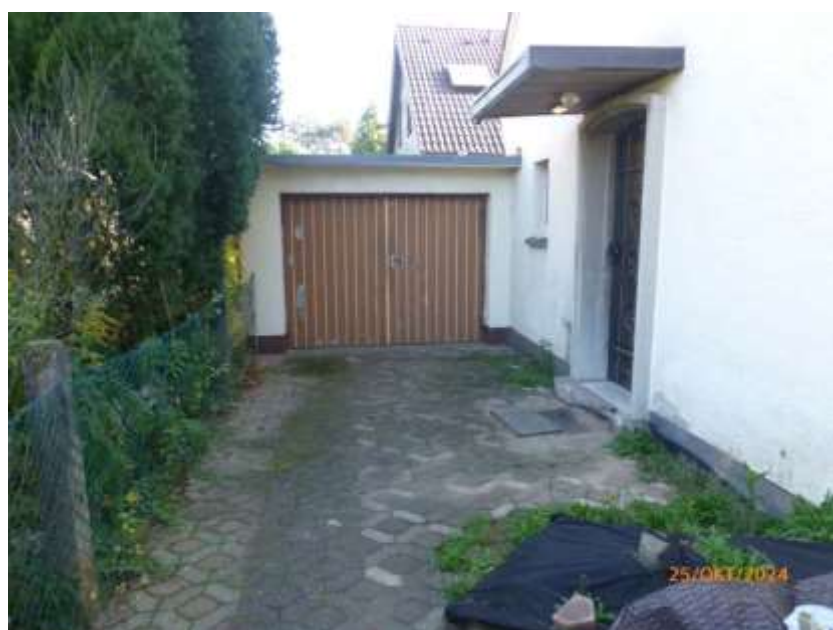
Ansicht von Westen, Hauseingang
