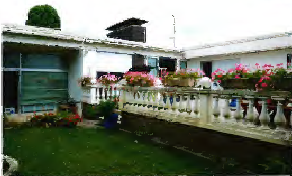
Bild 4: Ansicht von Süd-Westen, li eh. Schwimmhalle
