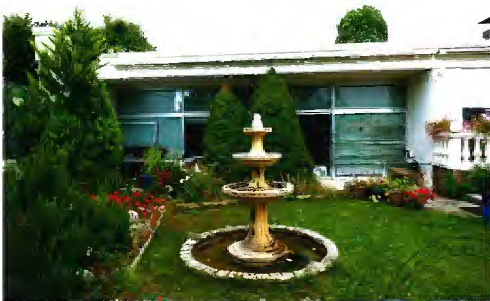
Bild 3: Ansicht von Süden, Blick auf die eh. Schwimmhalle
