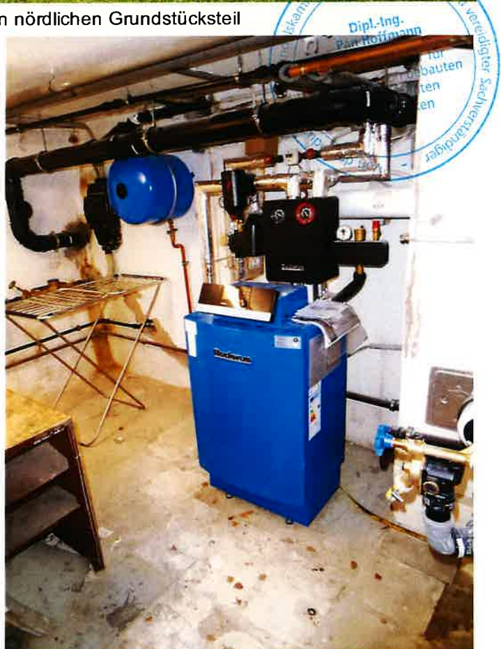
Bild 6: Heizkessel im KG
