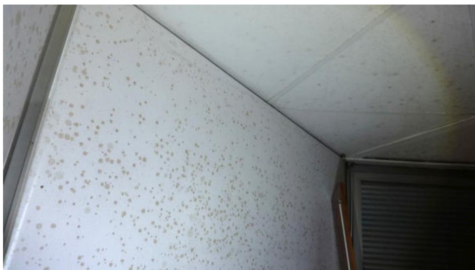
Feuchteschäden / Schimmelpilz
