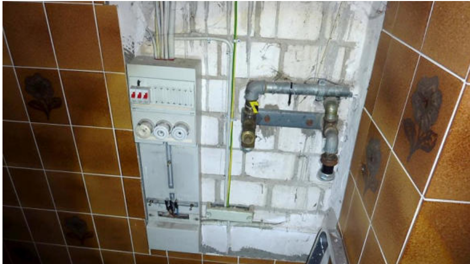
überalterte Elektrotechnik
