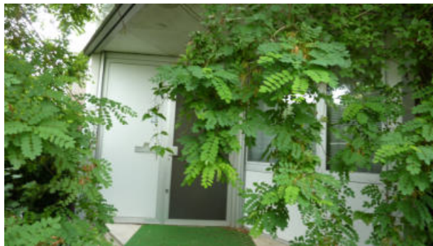
zugewucherter Hauseingangsbereich mit Flachdach
