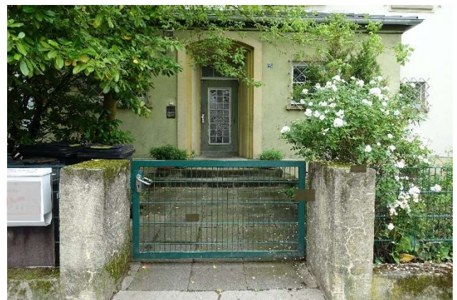
7.2.12 Gartentor und Hauseingang, Blick von der Straße Richtung Südwesten
