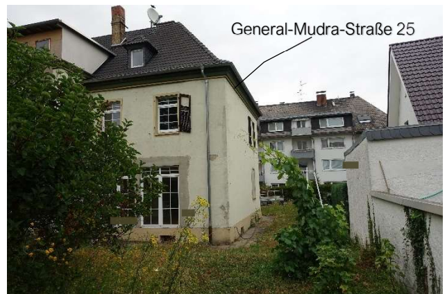
7.2.8 Südwest- und Südostfassade, Blick vom Garten Richtung Nordosten
