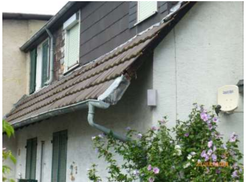
Ansicht von Süd-Osten
