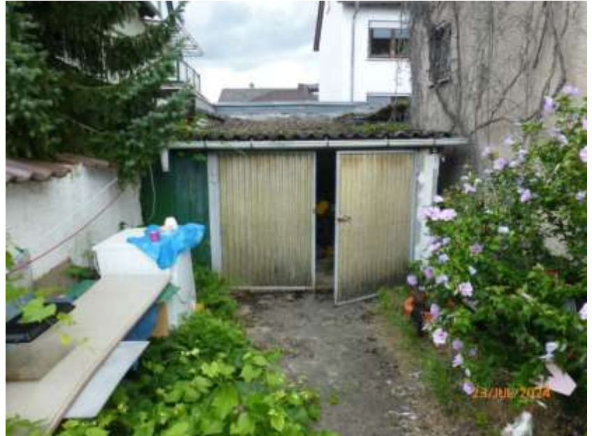
Ansicht von Süden, Garage 1
