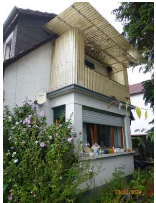
Ansicht von Süd-Osten
