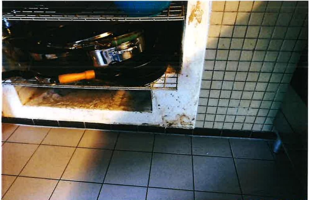
Bild 5: Einliegerwohnung KG im Sockelbereich Putzschäden mit Aussalungen und Schwarzsimmelbildung dringend zu sanieren, da im bewohnten Bereich der Einliegerwohnung Küche/ Essbereich KG Süd
