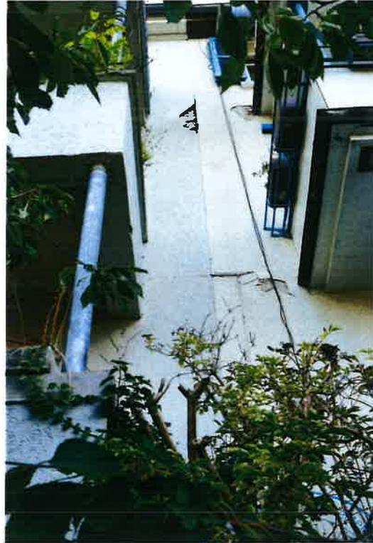
Bild 3: Putzschäden im Bereich des Außenputzes an der Südfassade/Ostgrenze
