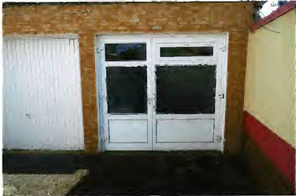
Bild 6: Blick auf die Doppelgarage
