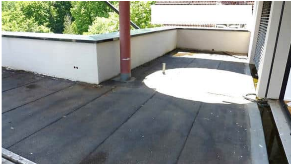
Dachterrasse im Staffelgeschoss mit Fertigstell.arb.
