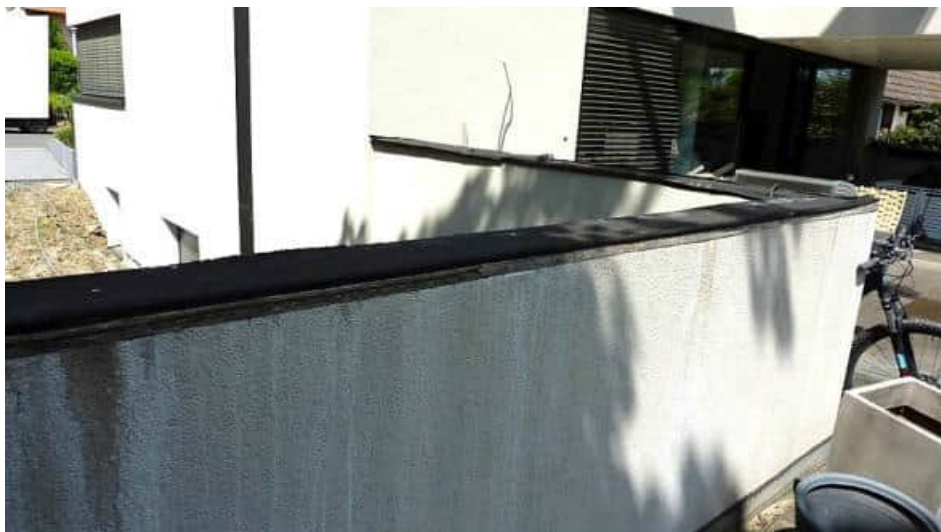
Mauerabdeckungen mit Fertigstell.arb.
