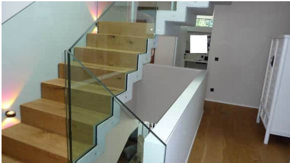
Treppe OG / Staffelgeschoss seitlich noch zu verkleiden
