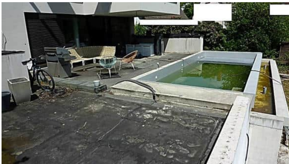
gr.Terrasse EG / Flachdach Garagenbau mit Fertigstell.arb. und Freischwimmbecken
