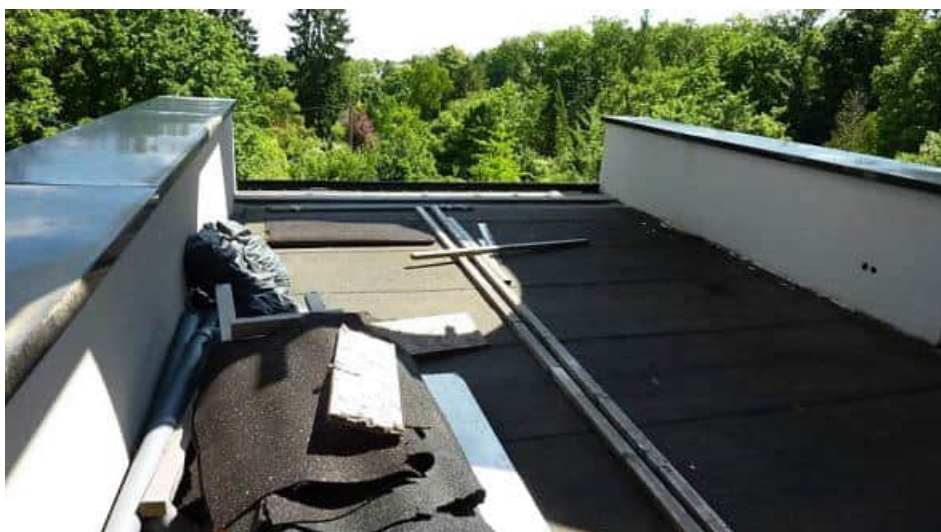
Dachterrasse Bodenbelag und Geländer mit Fertigstell.arb.
