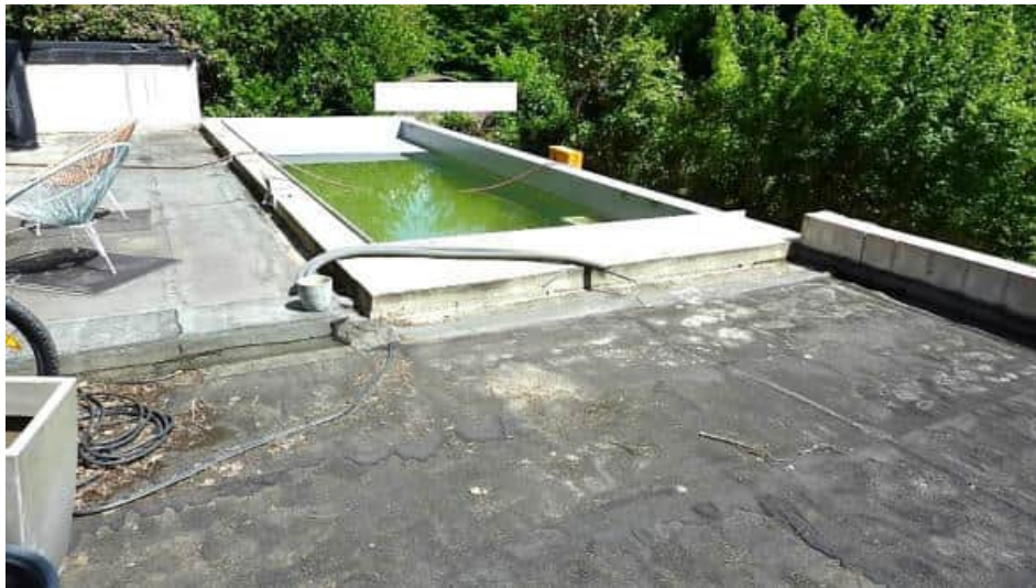
Terrasse EG und Flachdach Garagenbau mit Fertigstell.arb.
