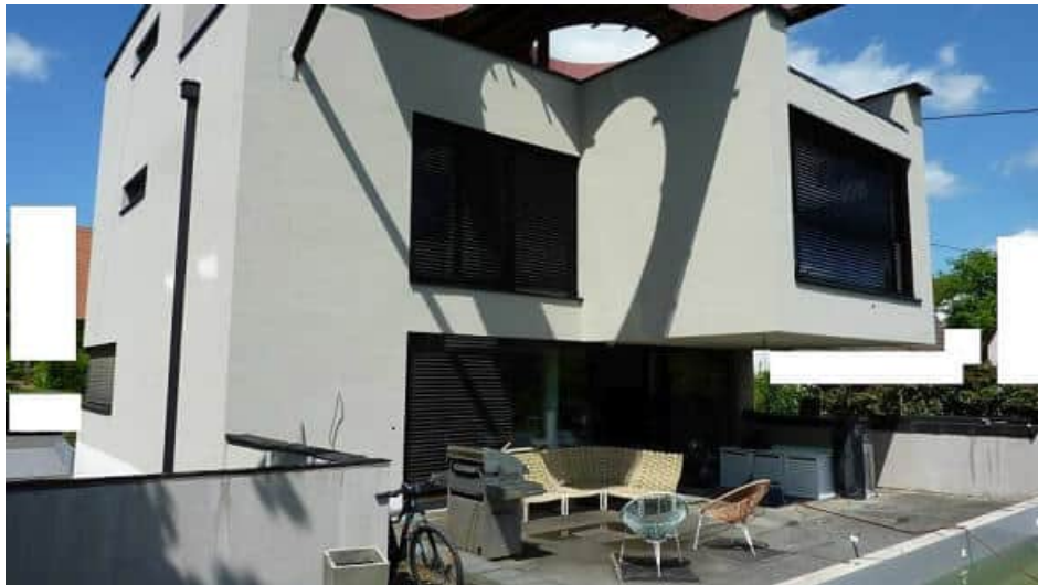
Rückansicht mit Terrasse EG mit Fertigstell.arb.
