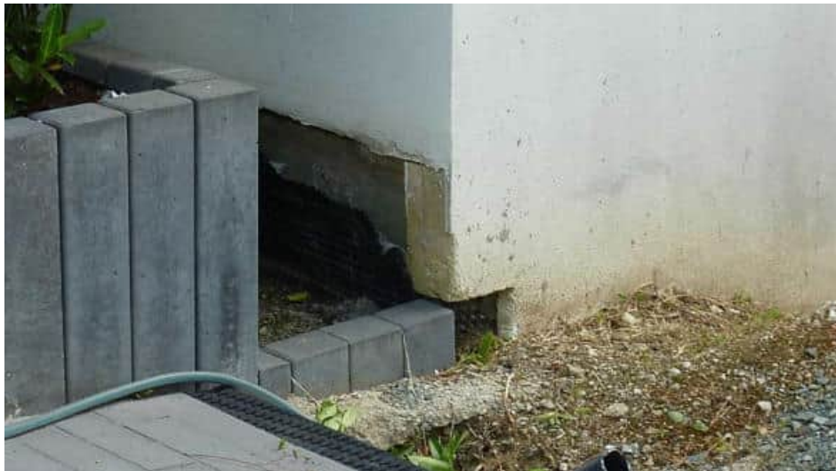
Haussockel mit Fertigstell.arb.
