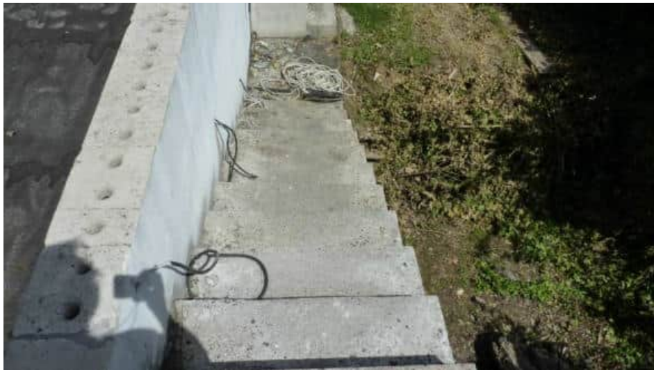
hintere Außentreppe mit Fertigstell.arb.
