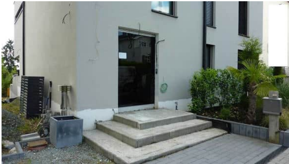
Außeneingangsbereich und Sockel mit Fertigstell.arb.
