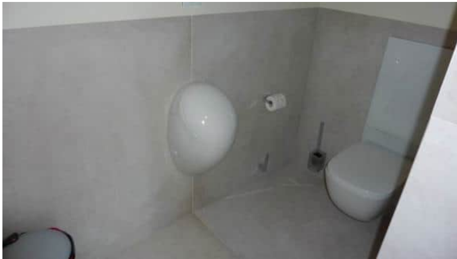
WC-Ecke im Bad Staffelgeschoss
