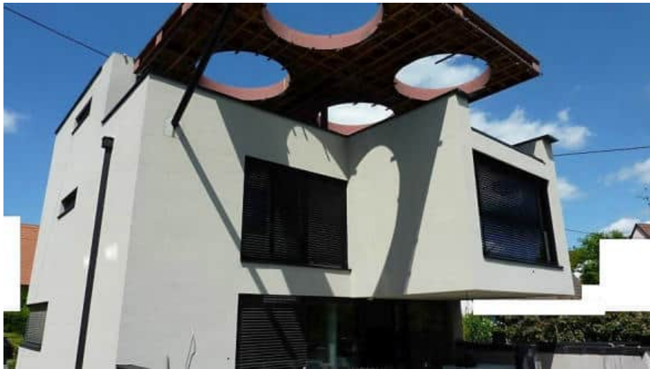
Rückansicht mit Dachterrassenüberdachung mit Fertigstell.arb.
