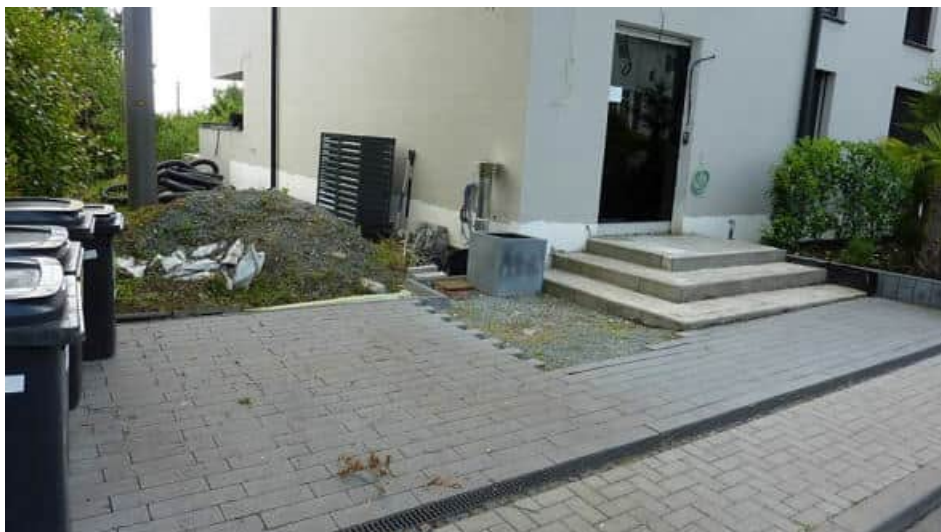
Eingangsbereich / Hofbefestigung / seidl. Gartenbereich mit Fertig.stell.arb.
