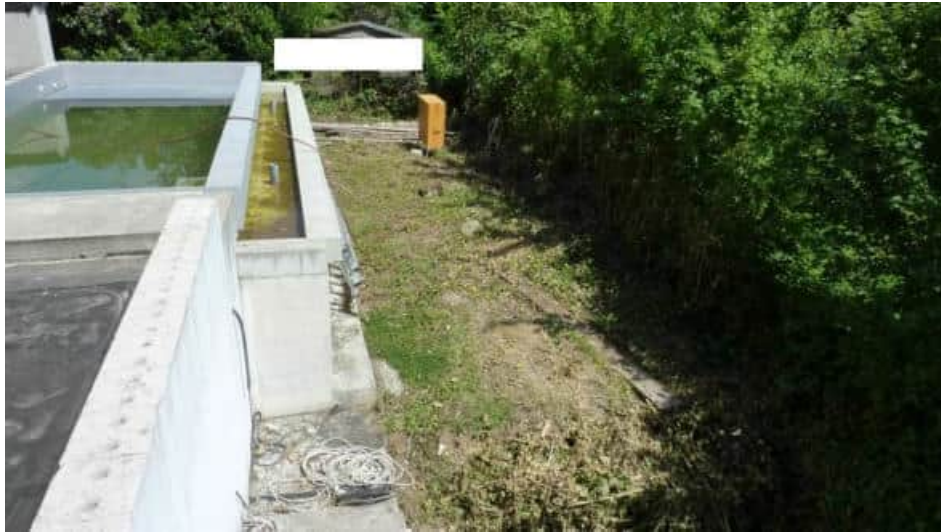
hinterer unterer Gartenbereich mit Fertigstell.arb. (tlw. Überschreitung Baugrenze)
