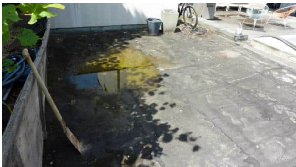
Flachdach Garagenbau mit Fertigstell.arb.
