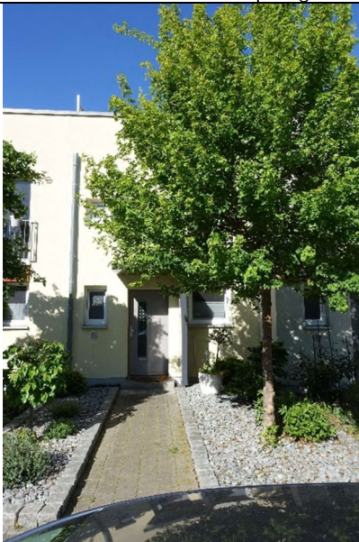
Ostfassade und Vorgarten, Blick vom Gehweg Richtung Westen
