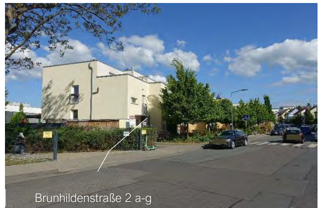
7.2.6 Straßenansicht, Blick aus der Straße Richtung Nordwesten
