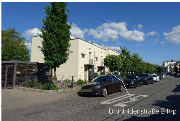
7.2.3 Straßenansicht, Blick aus der Straße Richtung Nordwesten
