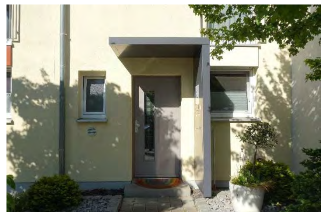
7.2.12 Hauseingang an der Ostfassade, Blick vom Gehweg Richtung Osten
