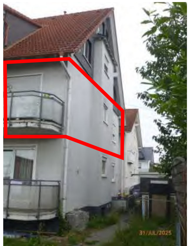
Ansicht von Süd-Osten
