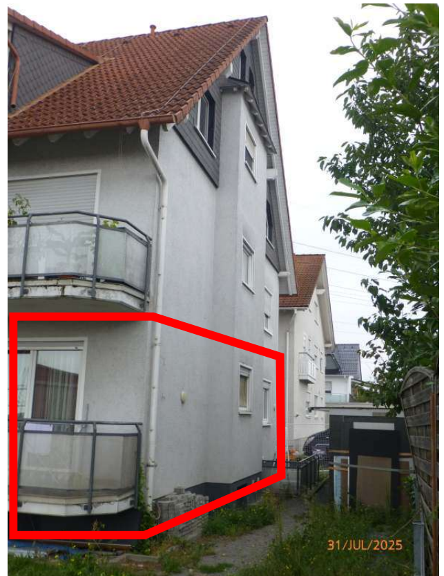
Ansicht von Süd-Osten
