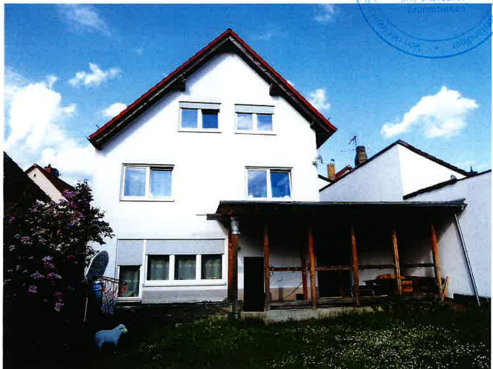
Bild 4: Rückansicht Hinterhaus von Süd-Westen
