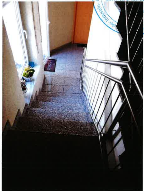
Bild 6: Blick in das Treppenhaus
