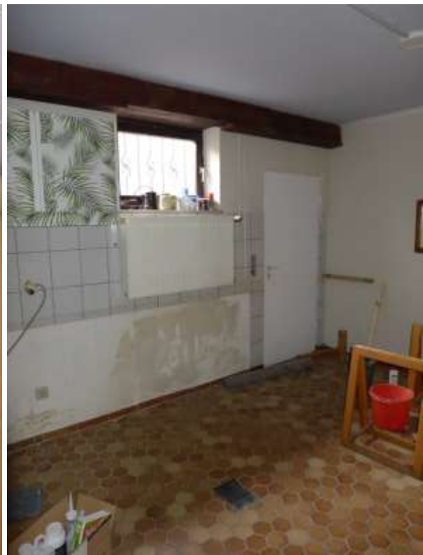
18 b Ausbau Kellergeschoss, Kellerausgang
