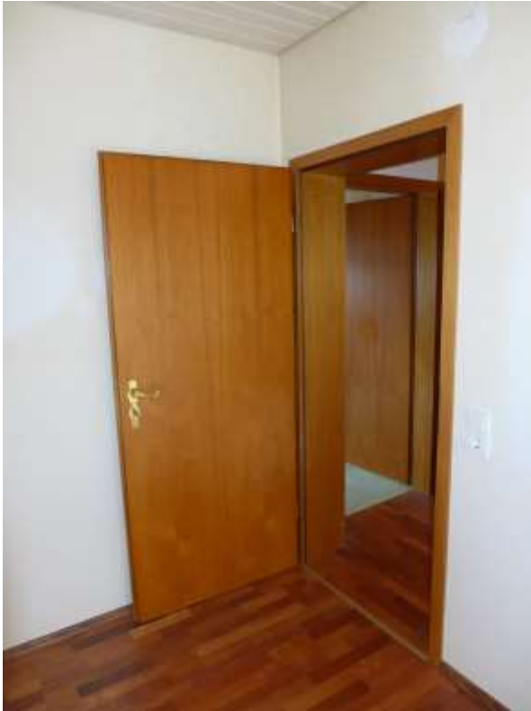
27 a Beispiel Innentüren Erdgeschoss
