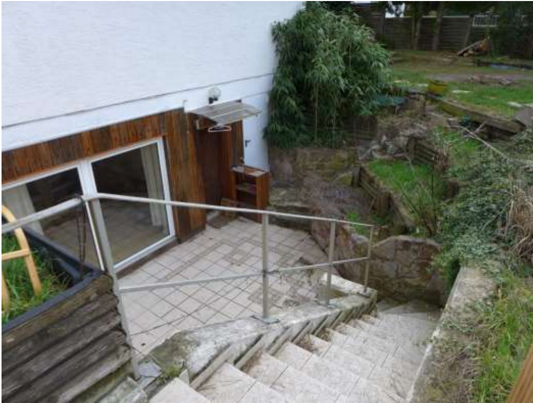
5 Außentreppe zur Einliegerwohnung
