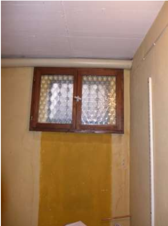
19 Zustand Ausbau Kellergeschoss
